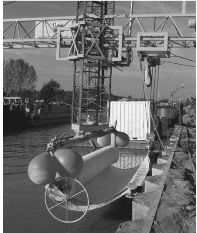
Bild 4: Verlegung der GTD
