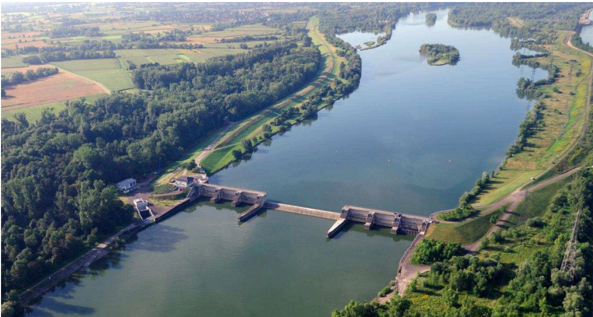
Abbildung 1: Wehranlage des Kulturwehrs Kehl/Straßburg mit dahinter liegendem Retentionsraum
