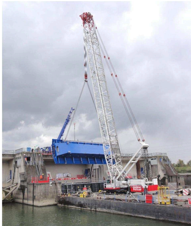
Abbildung 2: Einhub eines aufgearbeiteten Drucksegmentkastens mittels Schwimmkran
