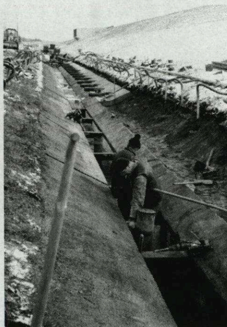
Bild 8: Aushub für den Filtereinbau im Entwässerungsgraben
