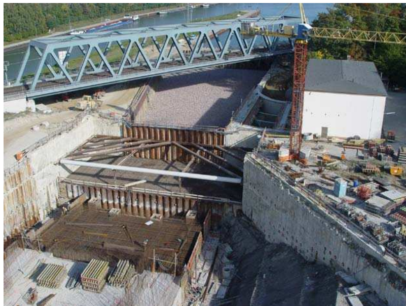
Bild 6: Ausgesteifte und verankerte Baugrube der Schleuse Sülfeld nahe der Eisenbahnbrücke.
