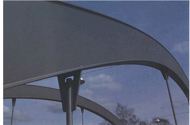
Bild 28: Dreiecks-Querschnitt der Brücke Hannoversche Strasse
