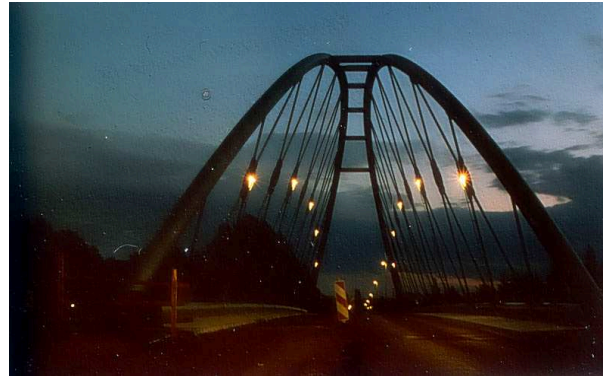
Bild 30: Das schöne Bild der beleuchteten Brücke Beneckeallee
