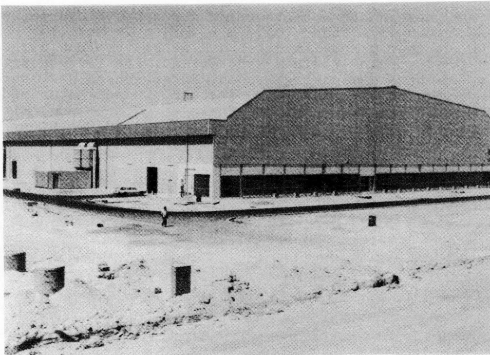
Bild 3 Ansicht der fertigen Modellhalle
