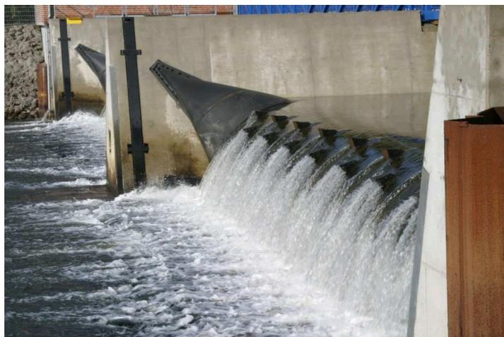
**Abbildung 1:** Schlauchwehr Bannetze an der Aller
