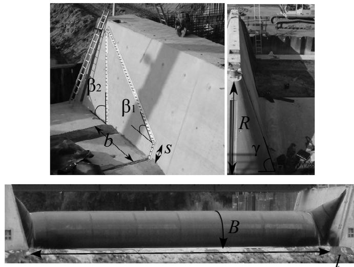
**Abbildung 2:** Geometrieparameter am Beispiel des Schlauchwehres Marklendorf
