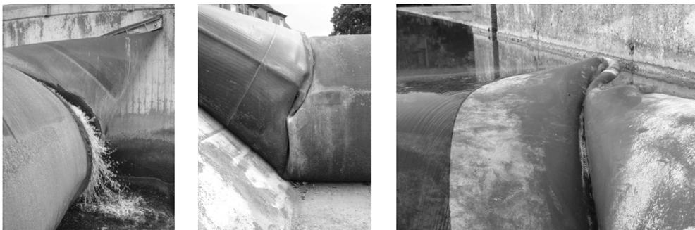
**Abbildung 7:** Schlauchwehre mit ausgeprägter Falte (Baiersdorf, Erlangen, Wertheim)
