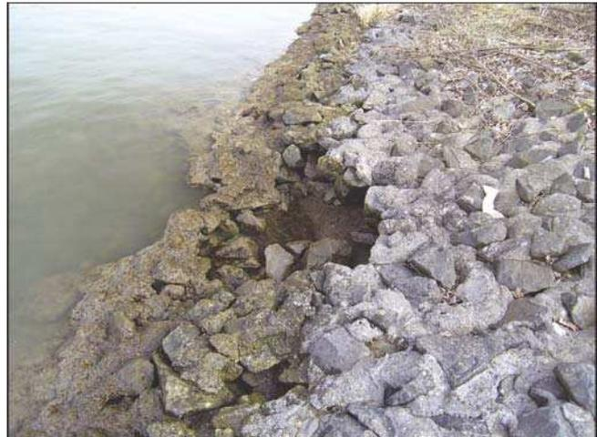
Bild 1: Uferabbrüche an einem zu dicht vergossenen, eigentlich durchlässigen Deckwerk
