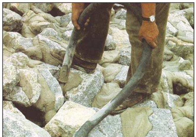
Bild 5: Beispiel für eine gute Ausführung mit einer richtig angepassten Pumpe
