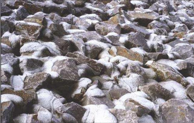
Bild 2: Beispiel eines mit dichtem Vergussstoff verklammerten durchlässigen Deckwerkes
