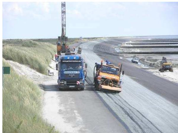
Fertiggestellte seeseitige Asphaltböschung
