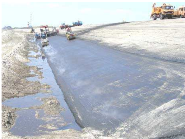
Einbau der unteren 6 m breiten Asphaltbahn
