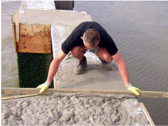
Einbau PCC-Mörtel
