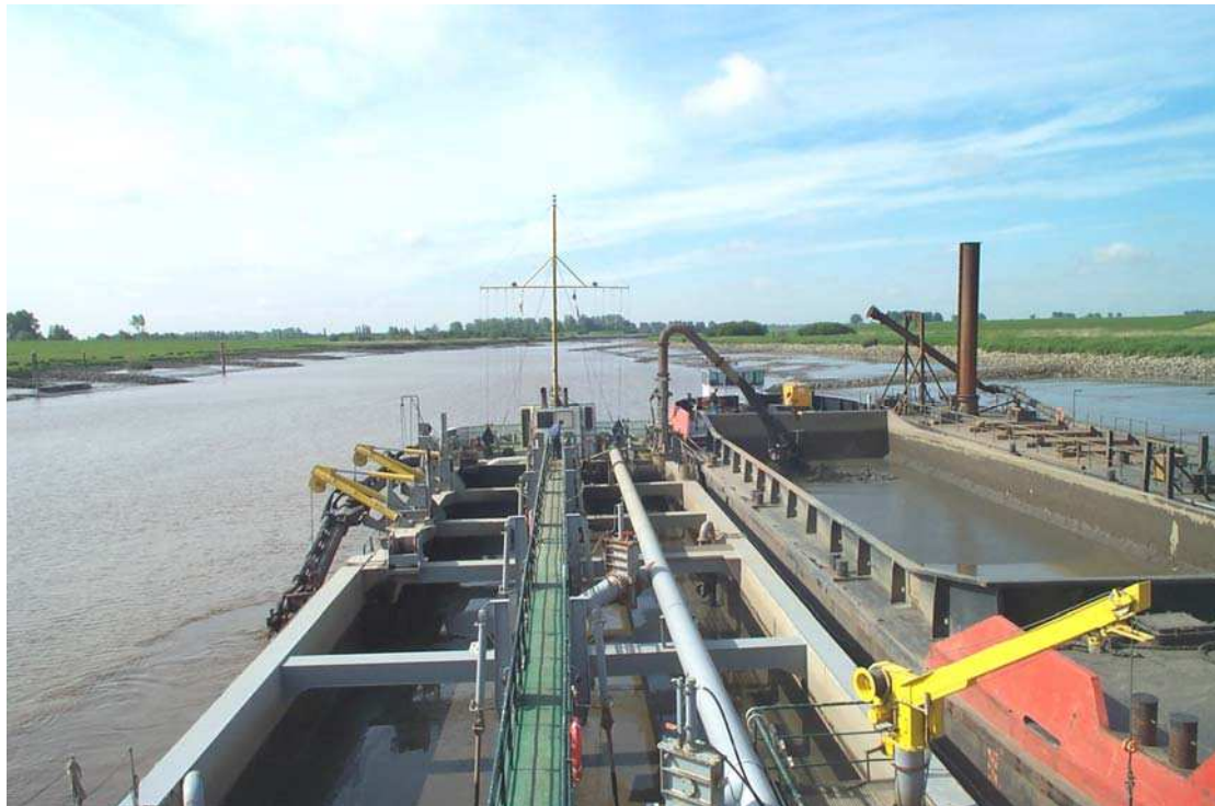
Bild 3: Beladevorgang einer Schute durch einen Hopperbagger
