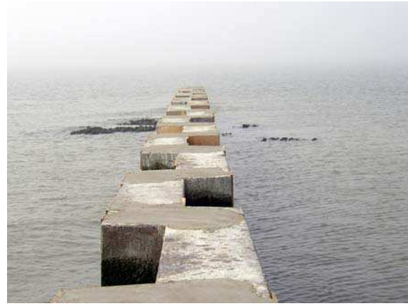
Nach Auffüllung mit PCC-Mörtel
