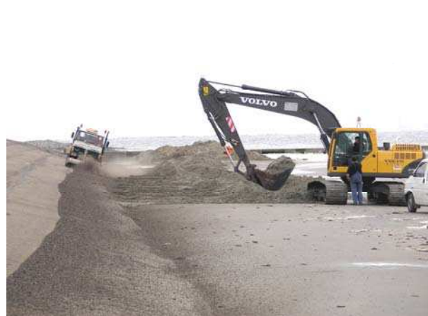
Freilegen und Reinigen der Asphaltoberfläche
