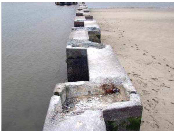
Nach Vorbereitung der Oberfläche
