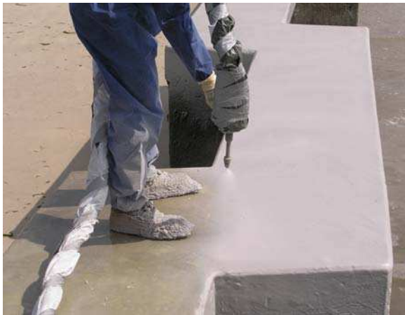
Auftrag der Oberflächenbeschichtung
