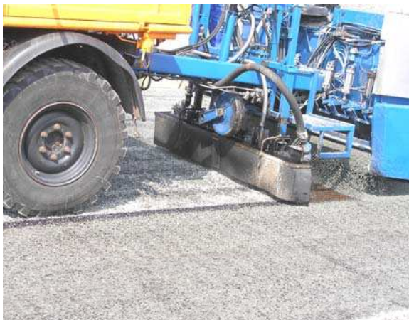
Maschinelles Aufbringen der Versiegelung
