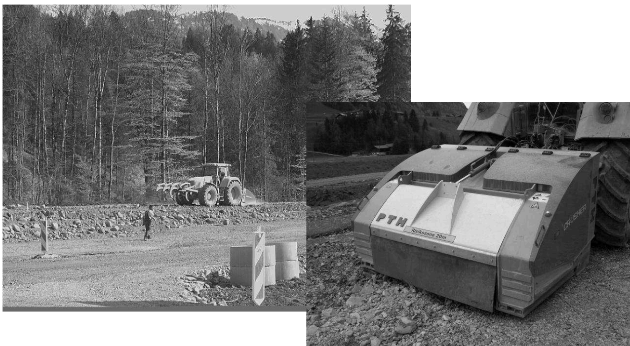
Abb. 1: Mobile Brecheinrichtung zur Homogenisierung des Kieses an der Einbaustelle
