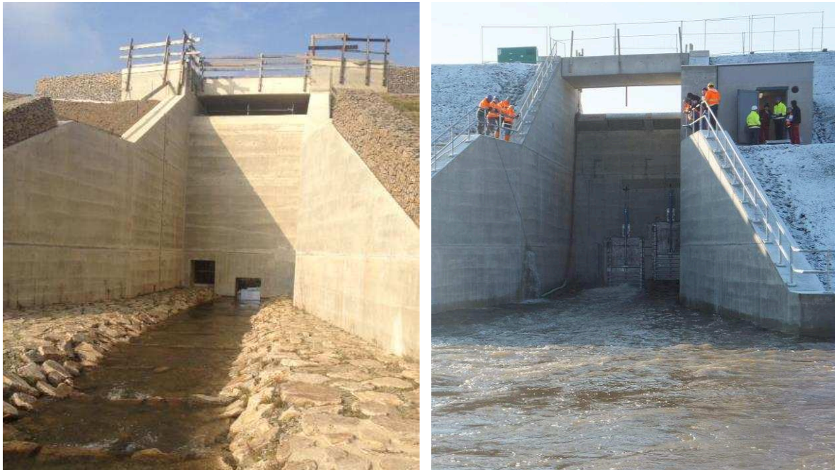
Abbildung 3: Auslaufbauwerk Wasser- und Luftseite
