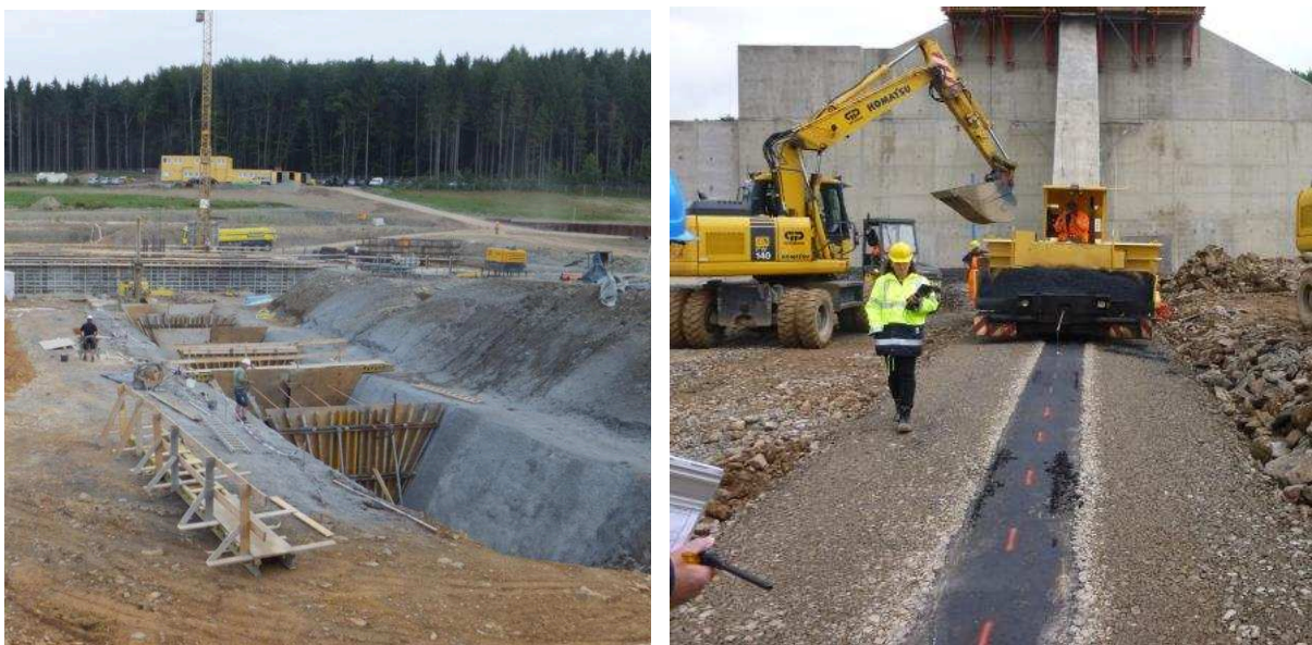
Abbildung 2: Herstellung Herdmauer und AID einschl. Übergangszonen mit Fertiger
