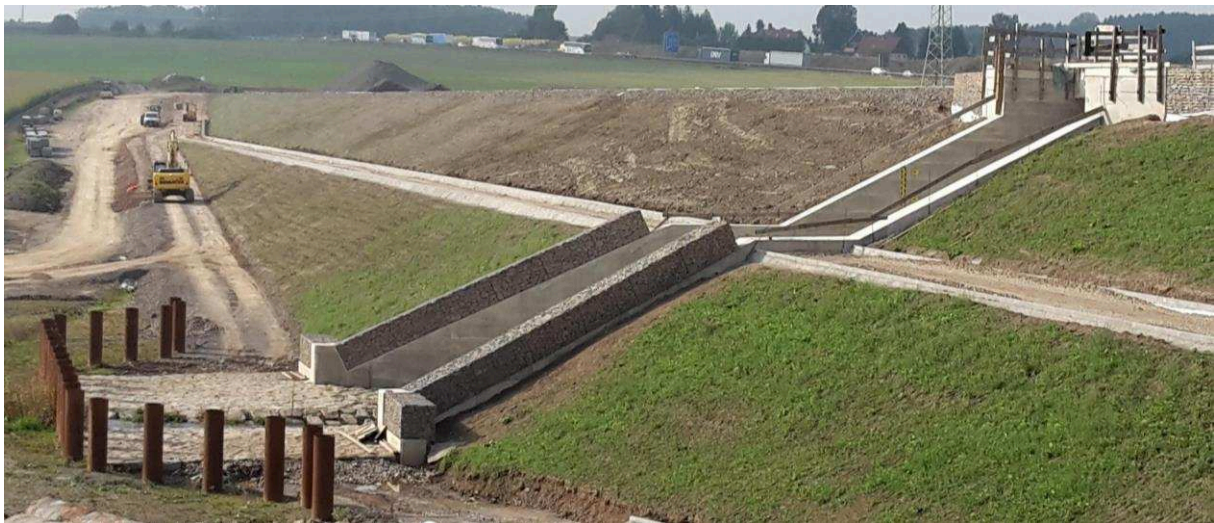
Abbildung 1: Absperrbauwerk Wasserseite mit Wildholzsperrung, Bauzustand 09/2016
