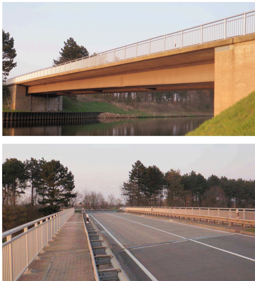
Bild 1: Straßenbrücke Nr. 23 bei Bockhorst, Seitenansicht (oben), Oberseite (unten)
