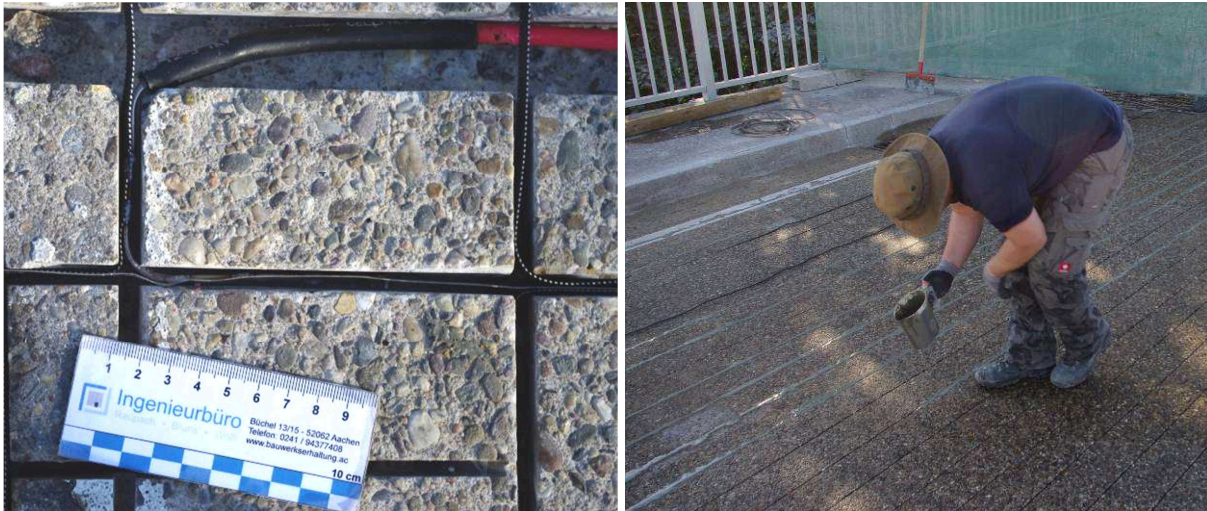
Bild 4: Links: In Schlitzen eingebettete MMO/Ti-Anodenbänder (im Bereich eines Anodenanschlusses). Rechts: Vergießen der Schlitze mittels des Anodeneinbettmörtels.
