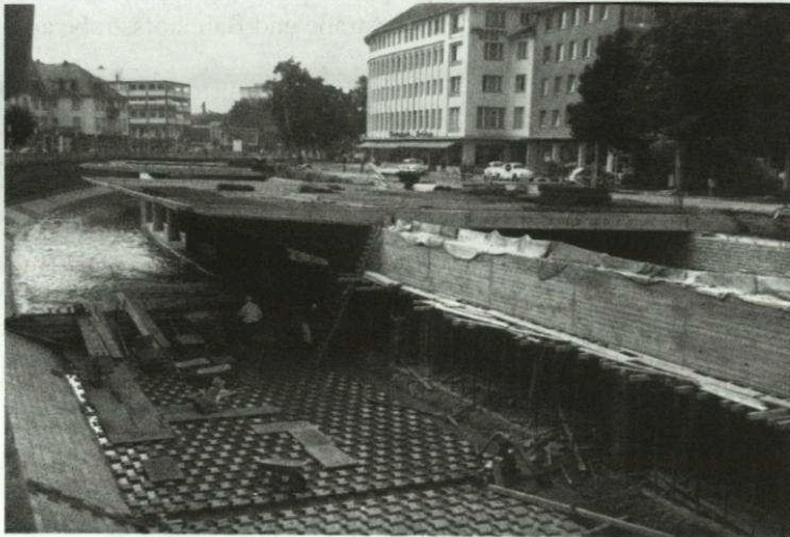
Abbildung 4: Ausbaumaßnahme Sohlbefestigung der Sieg und Herstellung Siegüberkragung 1968.
