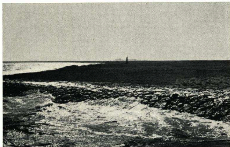
Abb. 7. Halligufener durch Deckwerk aus Granit und Basalt geschützt Aufn. E. WOHLBERG
