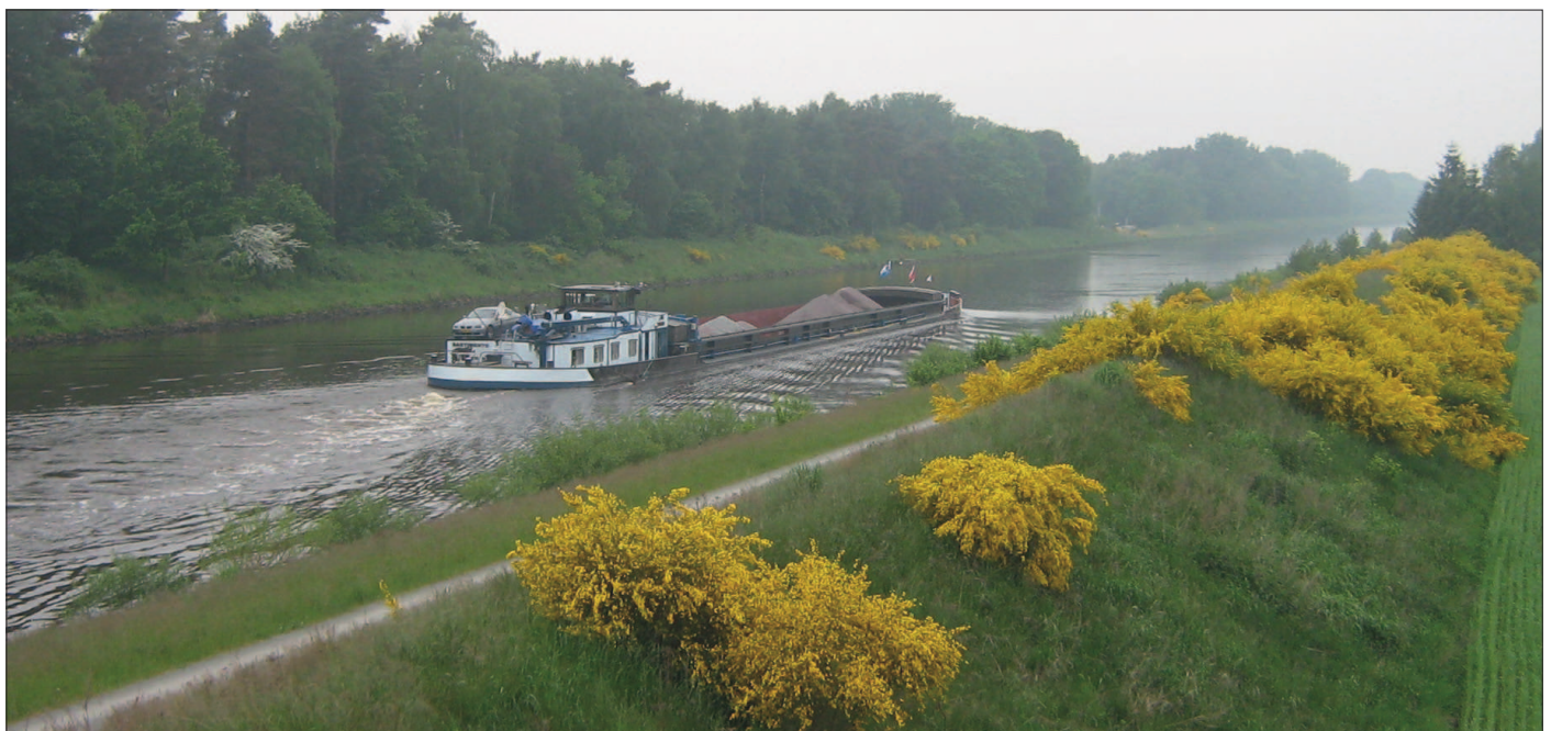
Bild 2.6: Kanal in Dammlage nahe einer landwirtschaftlich genutzten Fläche Figure 2.6: Embankment confined canal near agricultural area
