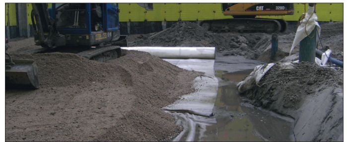
Bild 2.5: Herstellung Baugrubensohle Unterhaupt Schleuse Wusterwitz Figure 2.5: Preparing the bottom of the tail of the Wusterwitz lock
