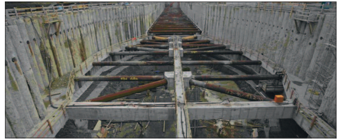
Bild 2.4: Baugrube Schleuse Bolzum Figure 2.4: Construction pit Bolzum lock
