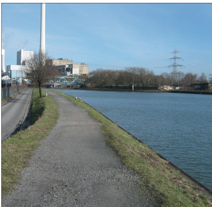
Bild 2.7: Kanal im Bereich eines Kraftwerks Figure 2.7: Canal in the vicinity of a power plant
