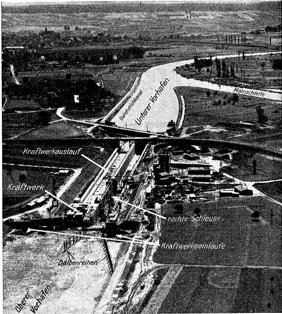
Bild 14 Schleuse und Kraftwerk der Mainstaufe Gerlachshausen. Bauzustand im September 1956.
