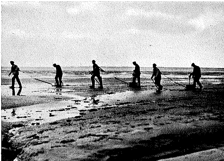
Abb. 23. Queller-Drill- kolonne besät nackte, bisher vegetationslose Watten.
