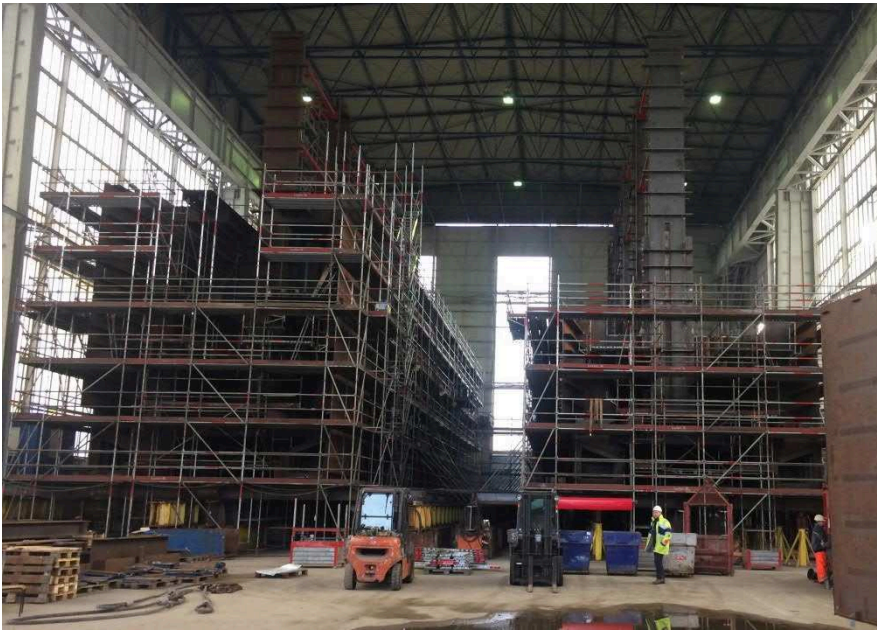
Bild 2: Fertigung der Schiebetore in der Schiffbauhalle in Emden (WSA Brunsbüttel)
