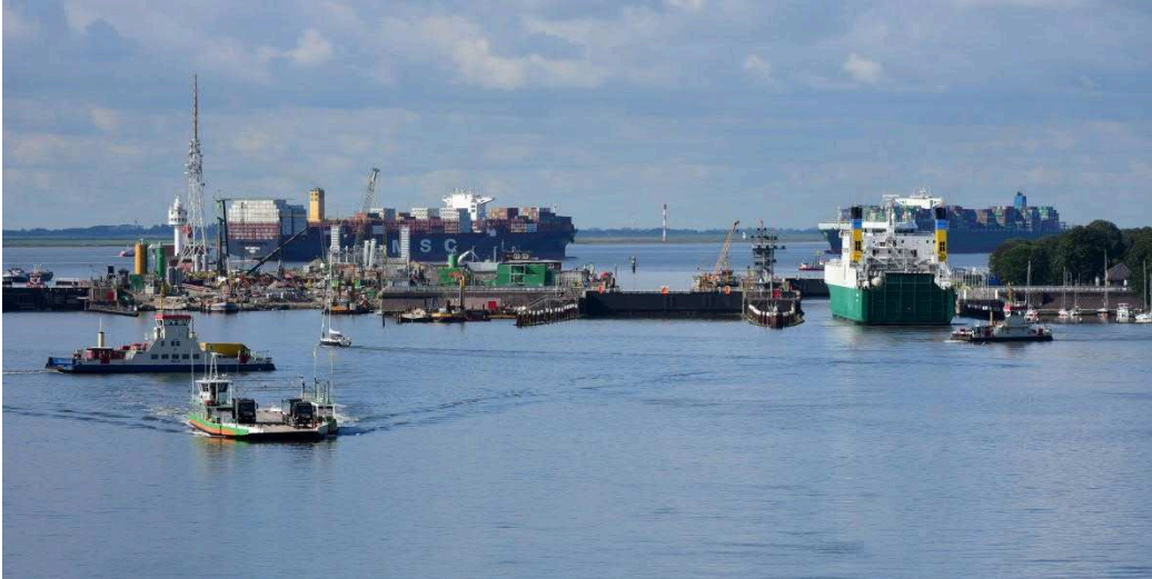
Bild 3: Schleuse und Baustelle (GDWS Kiel)
