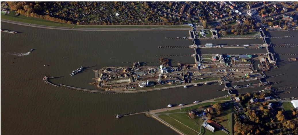
Bild 1: Luftbild der Schleusen Brunsbüttel (WSA Brunsbüttel)
