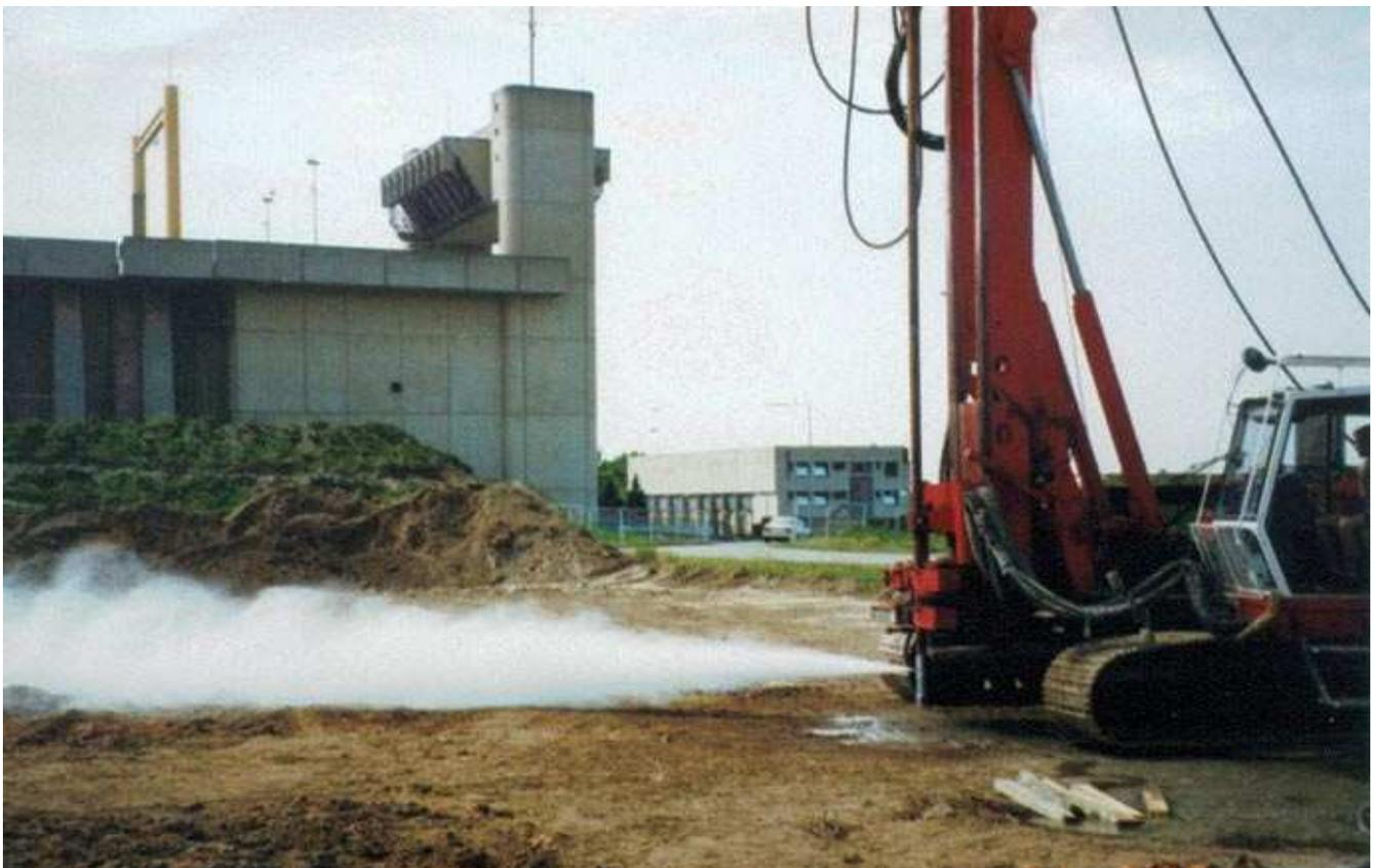
*Bild 6: Düsenstrahl-Bohrgerät*
