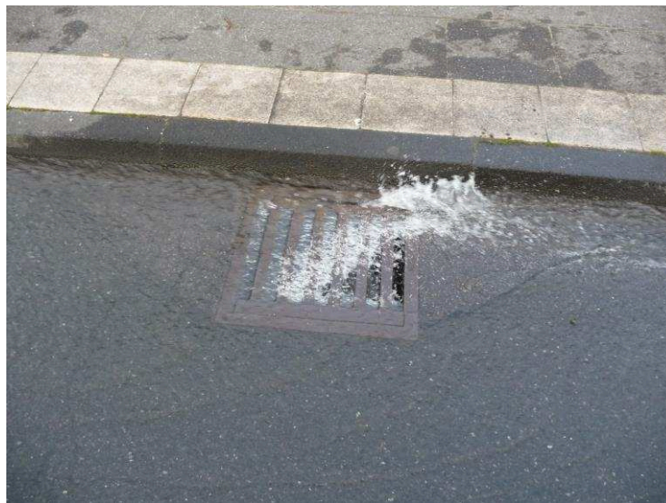
Abbildung 1: Überströmter Straßeneinlauf (Feldversuch)
