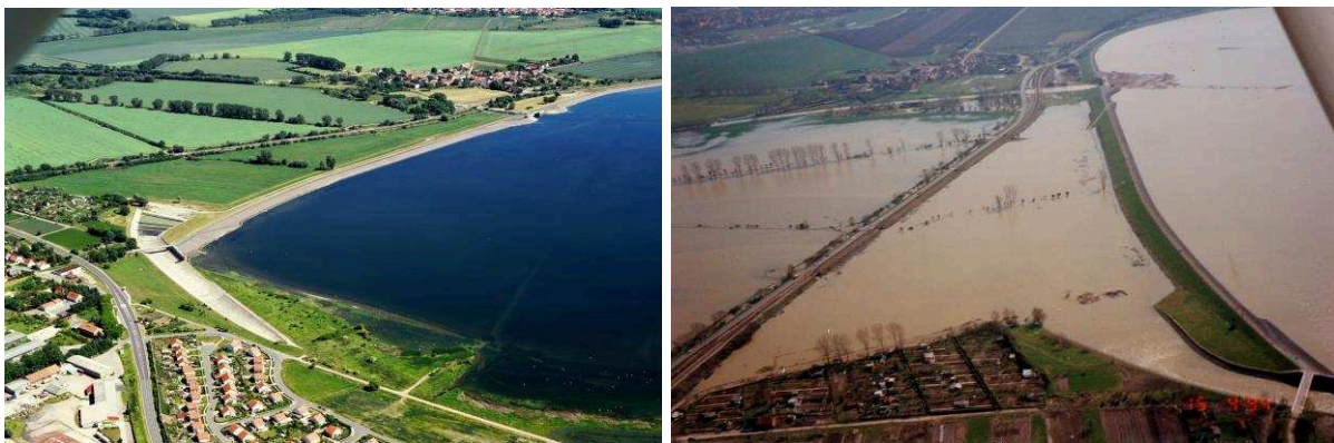
Abbildung 1: Hochwasserrückhaltebecken Straußfurt bei Normalbetrieb (sommerlicher Teildauerstau) und bei Hochwasserbetrieb 1994
