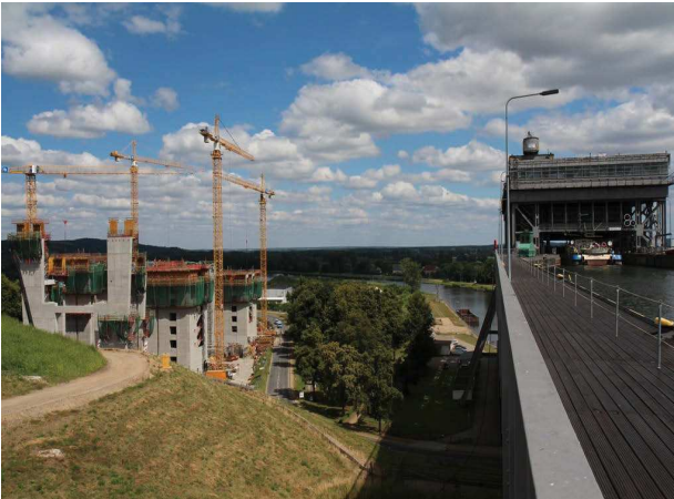
Abbildung 4: Neues Schiffshebewerk in Niederfinow – zurzeit im Bau
