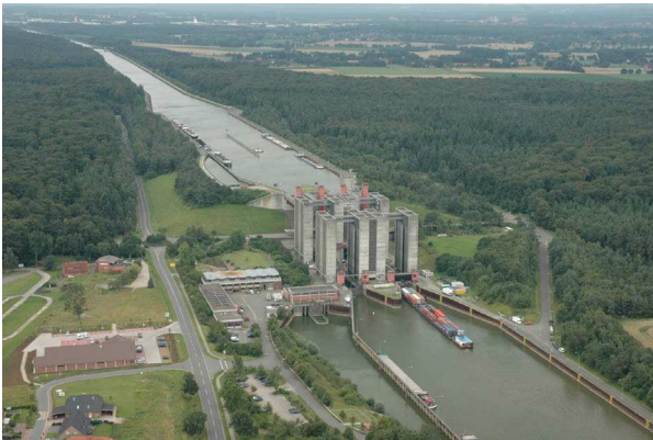
Abbildung 3: Schiffshebewerk Lüneburg bei Scharnebeck
