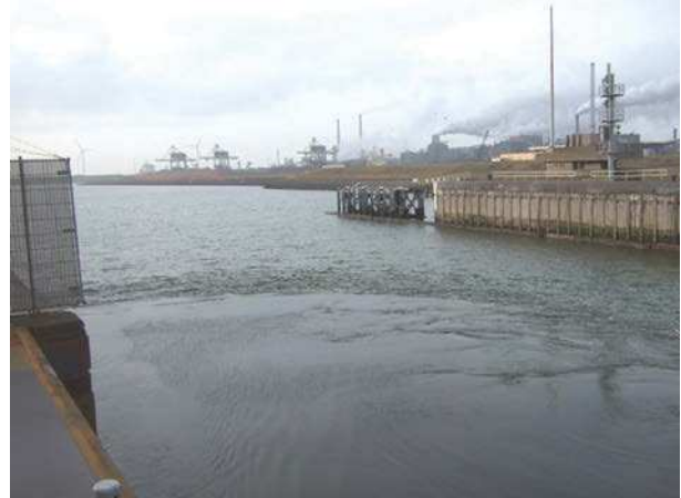
Bild 2: Oberflächennahe Ausbreitung der Frischwasserfahne nach der Öffnung des Schleusentores bei IJmuiden, Niederlande
