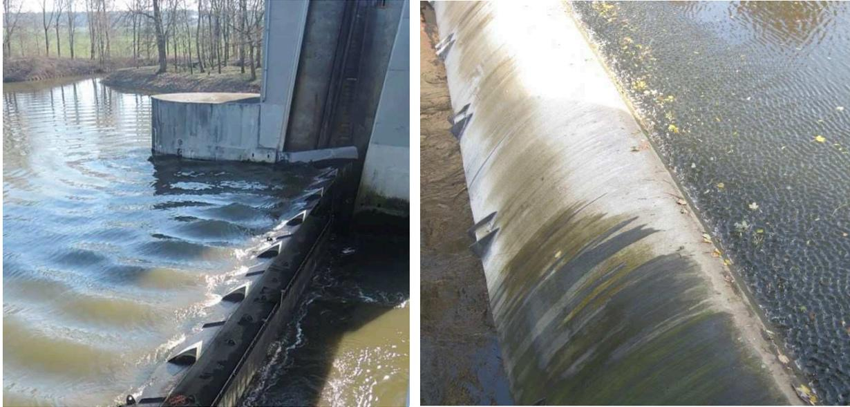
*Bild 3: Schwingungen eines unterströmten Hubschützes mit Aufsatzklappe (links) und eines Sohl-dichtungsträgers an einem Hubsenkenschütz (rechts)*
