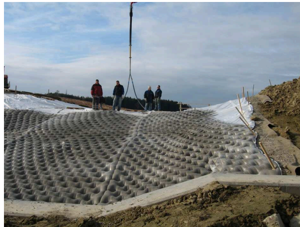
Abbildung 5: Einbau der Filterpunkt-Betonmatte in Kilb (AUT)
