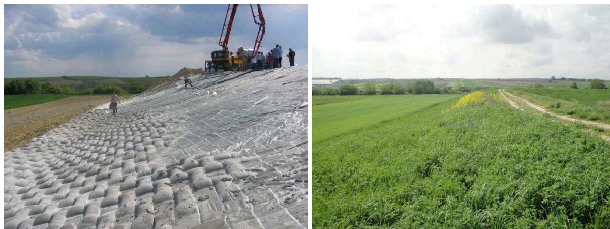
Abbildung 2: Luftseitige Dammböschung während des Einbaus (links) und fertiggestellter Überströmabschnitt nach Begrünung (rechts)
