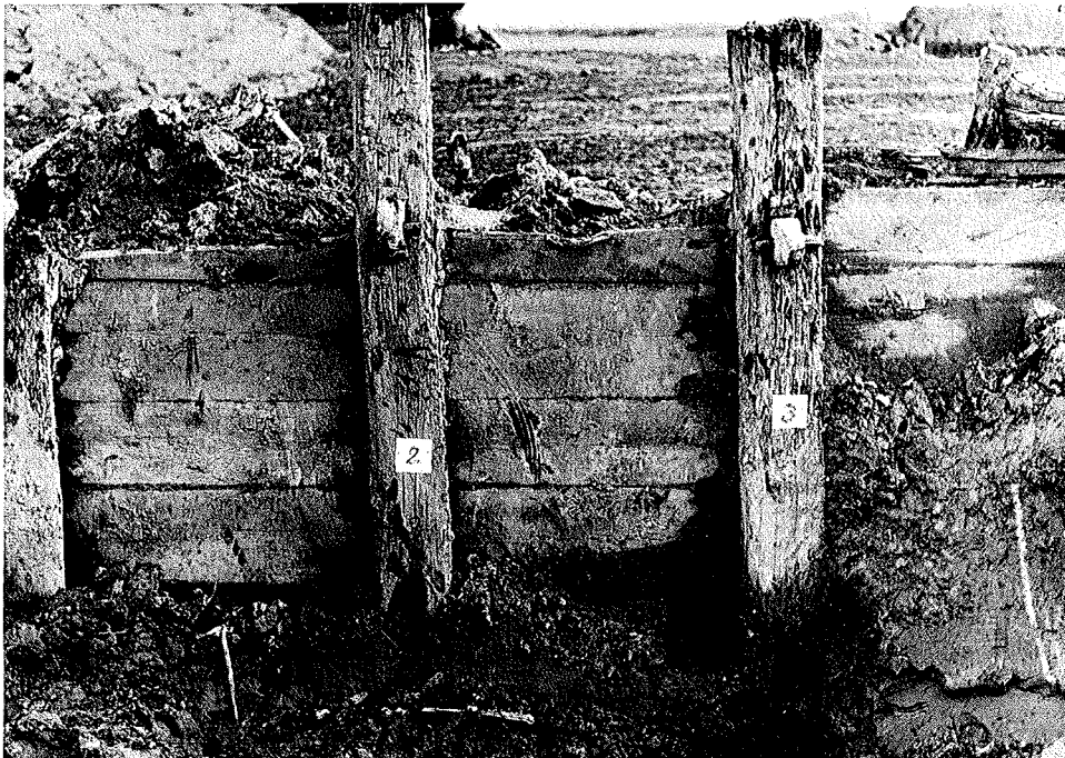
Abb. 10.9. Das Anfangsergebnis der zweiten Aufgrabungsphase. Das erste Grabungsfoto vom älteren Werk (Ost I) mit den rechtwinkelig gezimmerten Stammeichen und dem weitgehend nahtlosen Plankenwerk. Im Hintergrund Blick in die Südermarsch (Bezifferung der Stammeichen = grabungstechnische Zuordnung)
