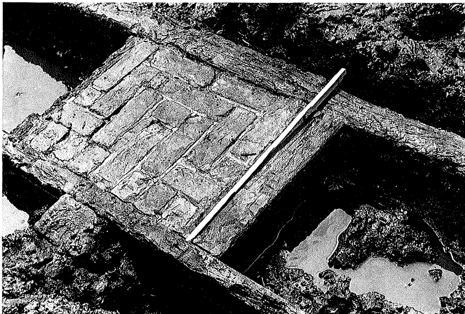
Abb. 5.6. Die trotz der Zerstörung des Hauses vollkommen unzerstört verbliebene Füllung des Gefaches mit Ziegelsteinen im historischen Klosterformat
