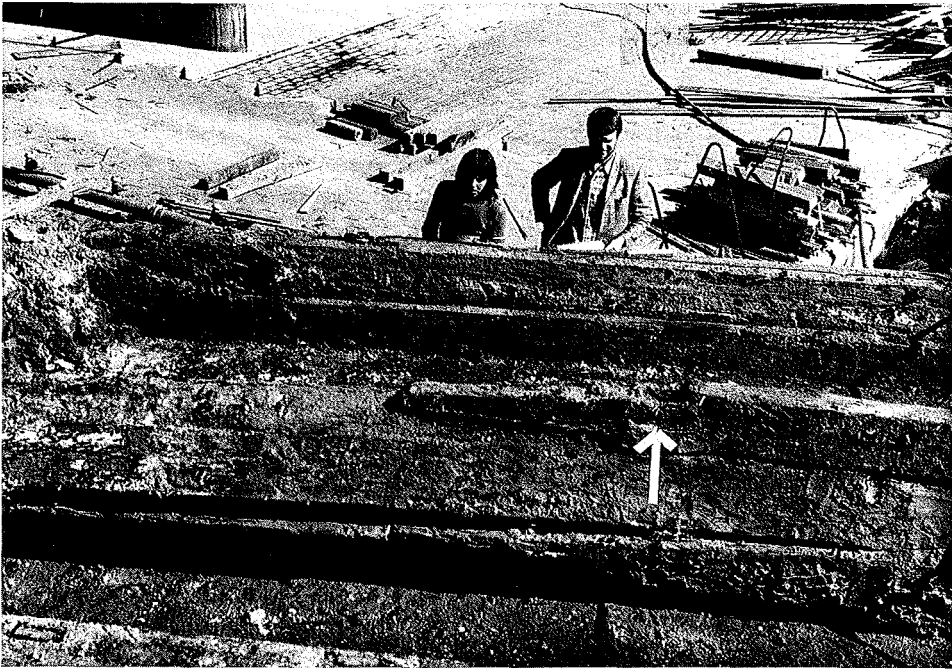
Abb. 9.10. In der Bildmitte Teil eines Sielkammerwandbalkens mit 80 cm Anblattung und rechts daneben der rechtwinklig herausgearbeitete Durchgang für den Richtriegel (weißer Pfeil)
