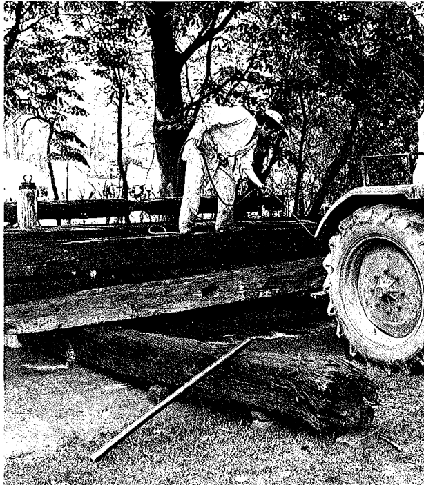
Abb. 9.12. Zwischenlagerung der Sielkammerwandbalken im Park des Nissenhauses zwecks Reinigung und Konservierung
