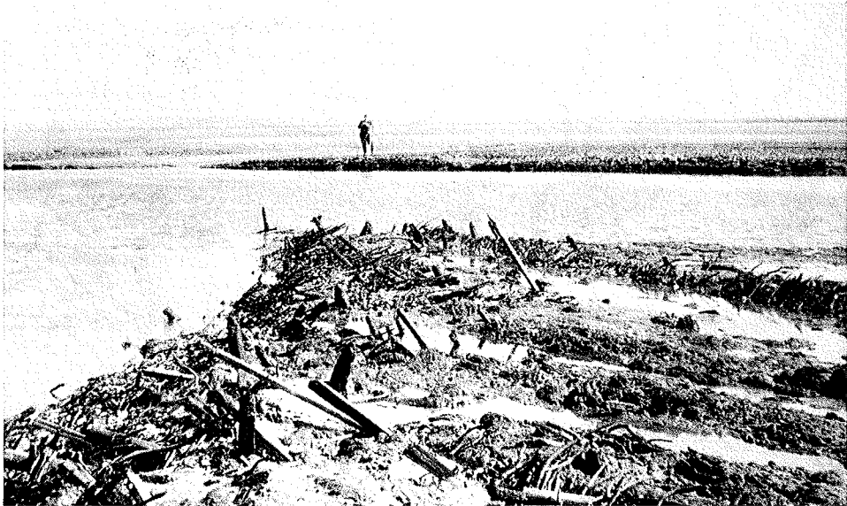
Abb. 11.5. (Standort d im Höhenplan Abb. 11.2) Im engeren Bereich des Vorflutkanals von Neu-Lundenberg-Siel taucht der vor 350 Jahren mit größtem Aufgebot an Deicharbeitern und Soldaten des Gottorper Herzogs einschließlich der Verwendung von Erdschiffen und allen verfügbaren Deichbaumaterialien versuchte Verbau der Hauptwehle bei extremem Niedrigwasser insel förmig auf
