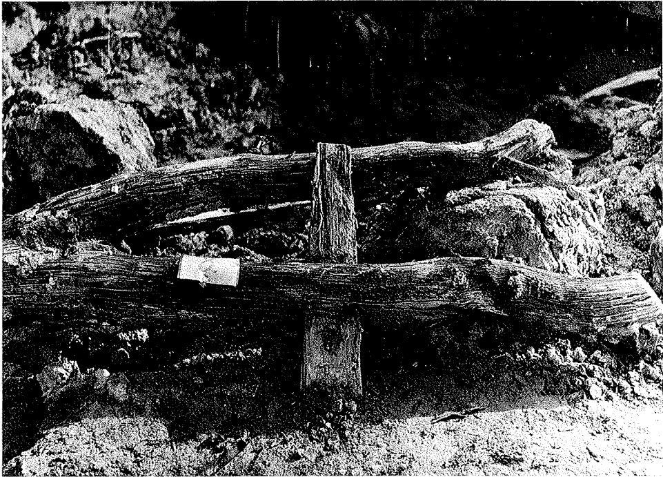
Abb. 10.19. Waldwüchsiger Gabelanker mit einem zwecks Verwendung auch auf „Zug“ in dem einen Gabelschenkel eingebauten Brettsplint, weil der zwischen den gewachsenen Gabelschenkeln liegende Winkel allein für die Montage der Funktionshölzer zu „engbrüstig“ ist
