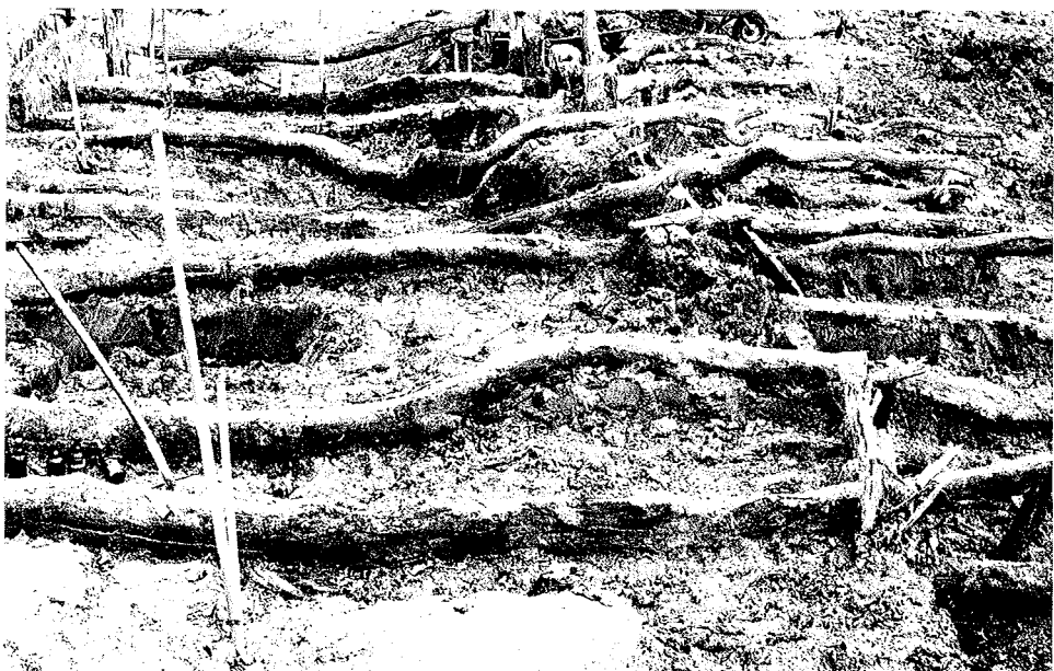
Abb. 10.12. Aufsicht auf die beiden nacheinander gebauten, durch verschieden lange Anker gesicherte und zum Doppelstackdeich vereinigte Deichkörper
