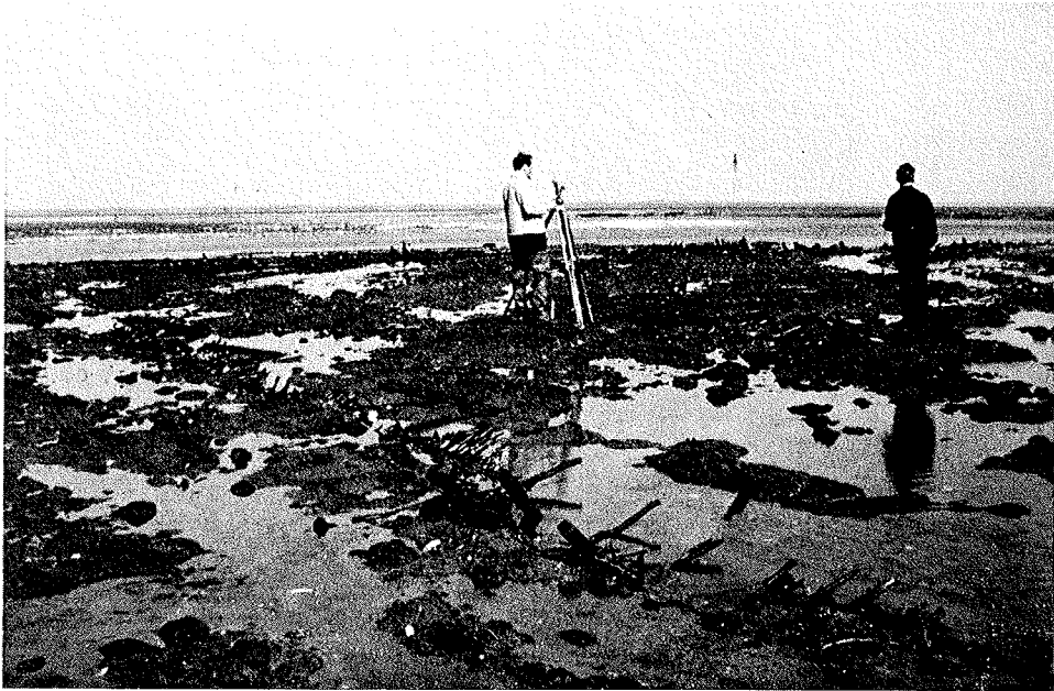
Abb. 11.8. (Standort d im Höhenplan Abb. 11.2) Das Zentrum des im Anschluß an die Sturmflut in den Jahren 1634, 1638–1643 mit größtem Materialaufwand vorübergehend geschlossenen Deichbruchs (vgl. Standort in der Handzeichnung Johs. Mejer 1637 – Abb. 11.3)
