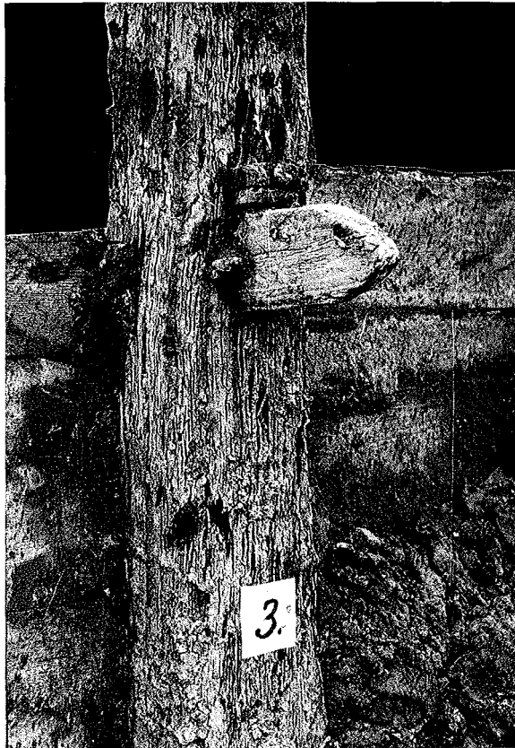
Abb. 10.14. In der dritten Aufgrabungsphase konnte das alte Werk (Ost I) in seiner ganzen, lt. Lageplan (Abb. 10.10) eingemessenen Länge freigelegt werden. Die Stammeichen waren zimmermannsmäßig rechtwinklig zugeschnitten und mit Hilfe der Zapflöcher auf das sorgsamste mit den Stackdeichankern verbunden. Was hier nicht durch den Splint auf Spannung montiert werden konnte, erhielt die funktionsgerechte Montage durch Einfügung von flachen Holzkeilen (s. Stammeiche 3)
