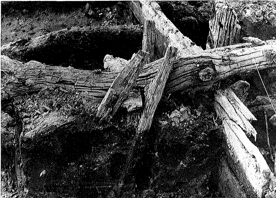
Abb. 10.17. Das ältere Ostwerk (Ost I), Abb. 10.7, A u. B zeigt zum Unterschied vom jüngeren Westwerk (West II) eine doppelte Plankenordnung. Darüber liegt im Foto ein hinter dieser doppelten Verbretterung festgesetzter Anker der Überlänge von Werk II
