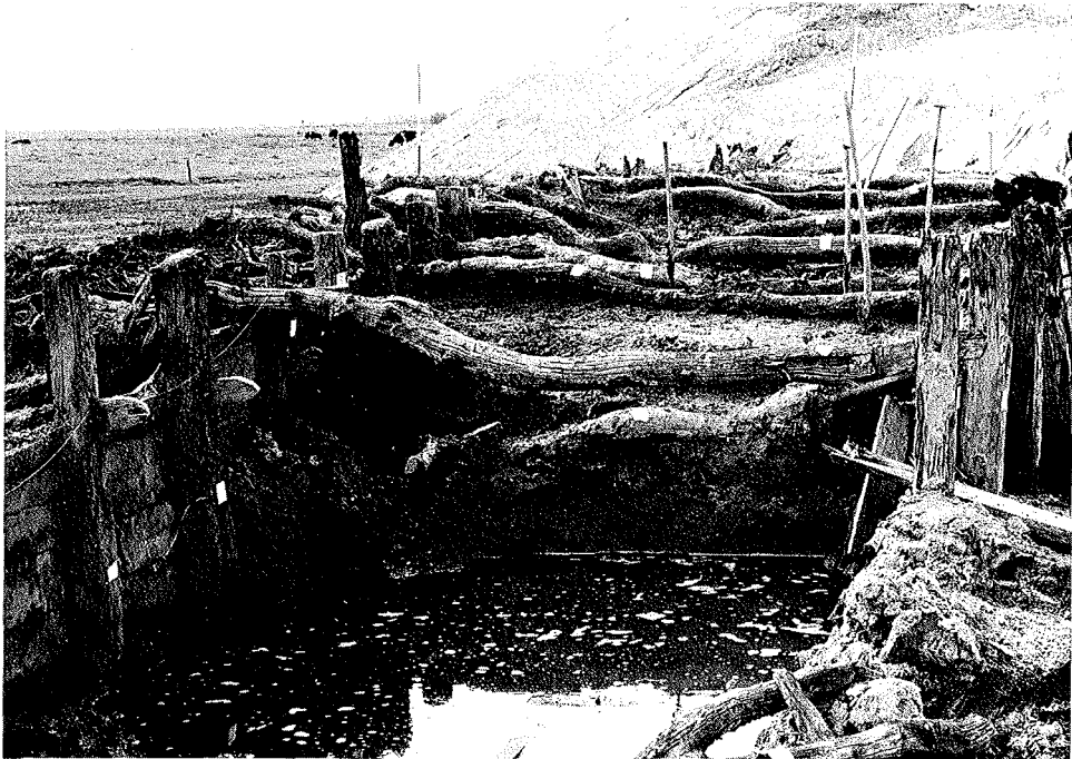
Abb. 10.5. Die Bergungsarbeiten am Doppelstackdeich wurden durch Grundwasseranstieg (vorne im Bild) erschwert
