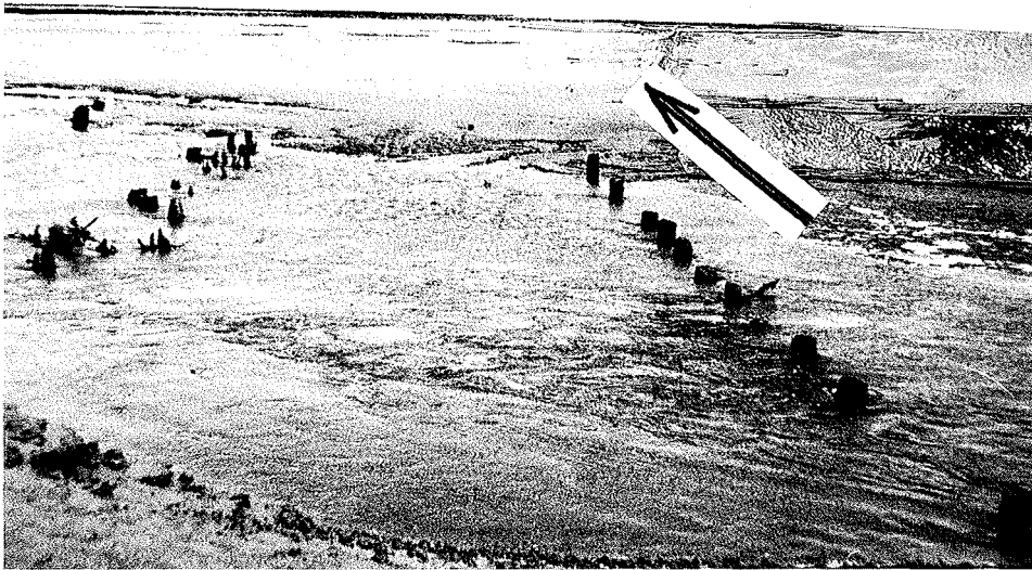
Abb. 7.7. Der Aufnahmestandort (Punkt c, Abb. 7.3) liegt südlich der Sandschaft Lundenberg. Die zu dieser geschlossenen Reihe von Stammeichen gehörigen Ankerhölzer sind nur noch zu einem geringen Teil erhalten geblieben. Der schwarze Pfeil zeigt die Richtung des weiteren Verlaufs des Stackdeiches unter einer Sedimentdecke von etwa 0,50 bis 0,60 m an. Diese Schlickdecke hat sich nach der Katastrophe von 1634 bis heute gebildet und auf diese Weise die historische Deichtrasse überdeckt
