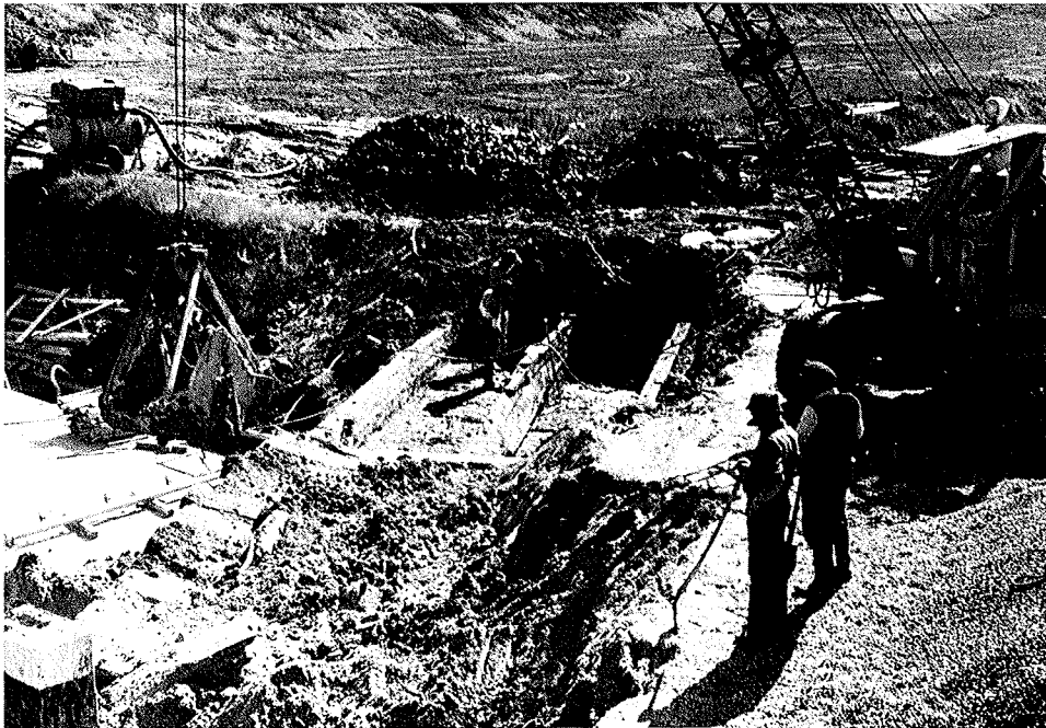
Abb. 9.4. Baustelle Schöpfwerk und Nüstersiel am „Halben Mond“ im Seedeich der Südermarsch-Lundenberg mit dem soeben freigelegten historischen Doppelsiel
