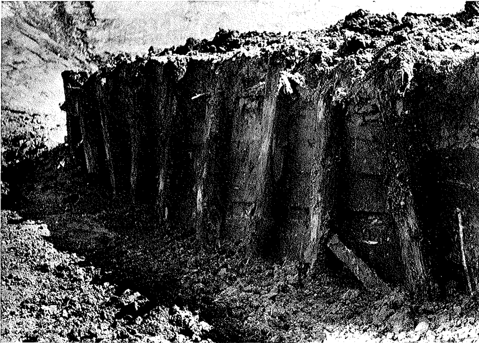
Abb. 10.6. Das Ergebnis der ersten Aufgrabungsphase: der dem älteren Stackdeich (Ost I) um rund 6 m nachträglich vorgebaute jüngere Stackdeich (West II). Hinter dem Bollwerk liegt zur Zeit der Aufnahme noch der volle Kleikörper
