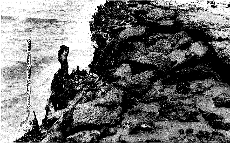
Abb. 11.15. Am hart umströmten Ufer des Vorfluters von Neu-Lundenberg-Siel zerbricht der alte, durch Humus nur schwach angereicherte Waldboden in einzelne Schollen. Der in der linken Bildhälfte aufgestellte Maßstab zeigt Höhe und Steilheit des Abtrags an der Kante des Vorfluters mit über 60 cm an
