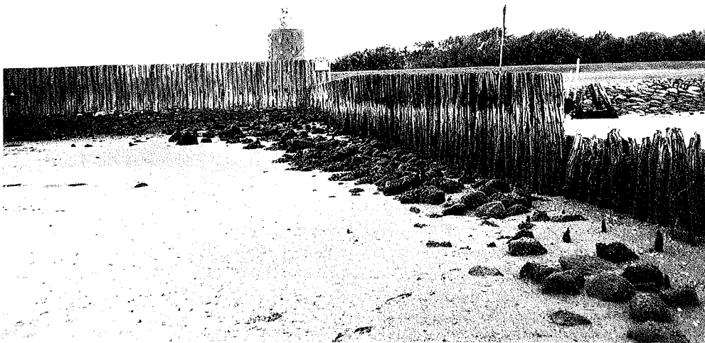
Abb. 8.8. Das Eichen-Bohlwerk auf der Insel Neuwerk als letztes noch in unseren Tagen in voller Funktion befindliches und technisch laufend unterhaltenes Bollwerk zum Schutz des grünen Vorlandes am Fuß des Seedeiches
