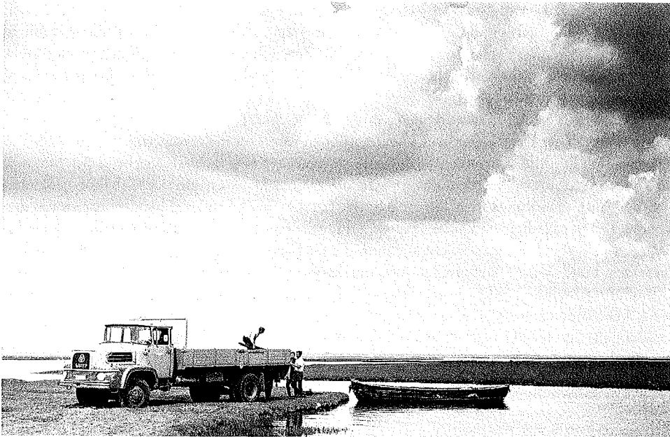
Abb. 5.11. Die vom Arbeitsboot während des Hochwassers auf den Lastwagen umgelagerten Fachwerkgebäude werden ins Depot zum Nissenhaus gefahren und dort konserviert eingelagert
