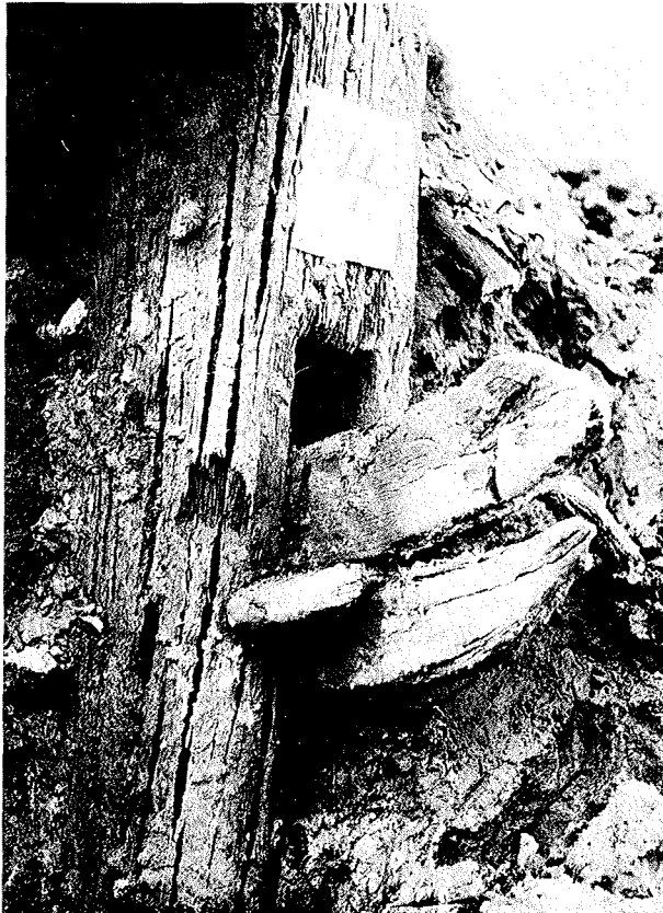
Abb. 10.15. Obwohl vor Jahrhunderten aus dem Kernholz der Waldeichen gezimmert, unterliegen die Stackdeichelemente (Abb. 10.16) nach der Öffnung ihrer jahrhundertelangen Einlagerung in dem tonigen und dauerfeuchten Substrat „Klei“ sehr schnell der Schrumpfung (hier Stammeiche mit der Grabungsnummer 4)
