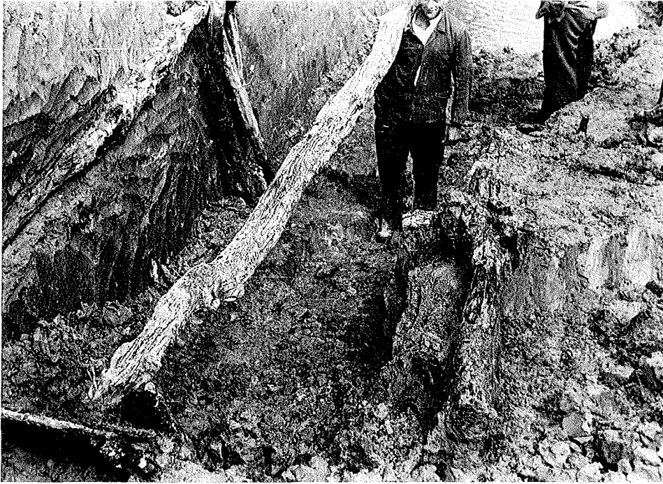
Abb. 8.2. In der deichbaugeschichtlichen Forschung wurde zum ersten Mal ein Stackdeich in originaler Konstruktion und Funktion freigelegt. Grabung 1949 im Seedeich bei Husum westlich der auffälligen Entwässerungsschleuse des Purrenkooges
