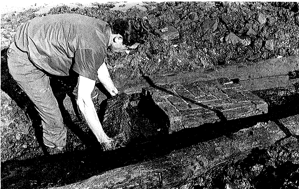
Abb. 5.8. Das Fachwerk wird aus der sorgfältig ausgeführten mittelalterlichen Verzäpfung gelöst und für den Transport nach Husum beiseitegelegt. Trotz der Lösung des Fachwerkes aus dem gezimmerten Verband blieb die Ziegelfüllung mit der Mörtelbindung durch den Muschelkalk „freischwebend“ ohne Holzgerüst erhalten
