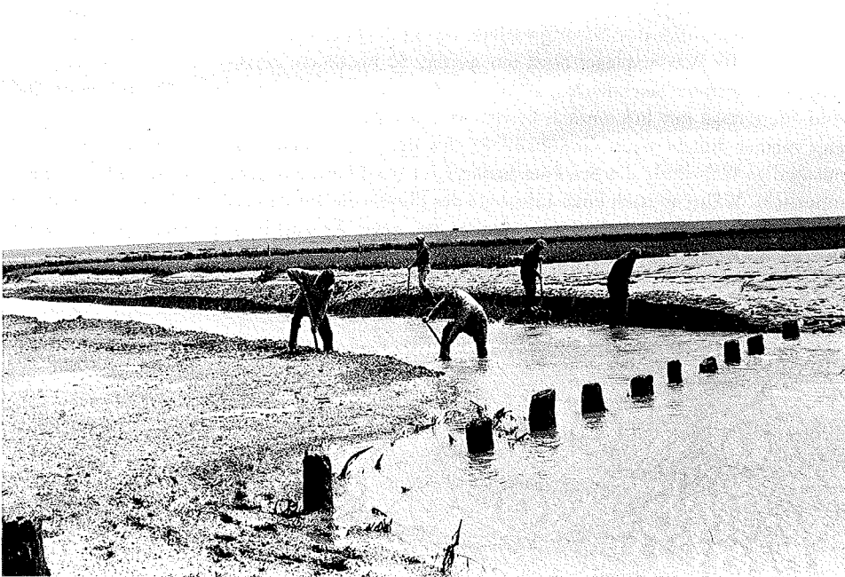
Abb. 7.2. Zwecks Erhöhung der Abflußgeschwindigkeit des im Spitkoog während des letzten Hochwassers angestauten Wassers wird der Querschnitt des durch Eigenerosion entstandenen Vorfluters durch Spatenarbeit vergrößert. Bei weiter fallendem Wasserstand werden die im Photo auf historischer Linie stehenden Stammeichen stärker über die Wasserfläche herausragen und schließlich auch die auf dem Photo noch unter Wasser liegenden Ankerhölzer freigegeben (vgl. Abb. 7.4 bis 7.6) Standort j im Höhenlinienplan Abb. 7.3
