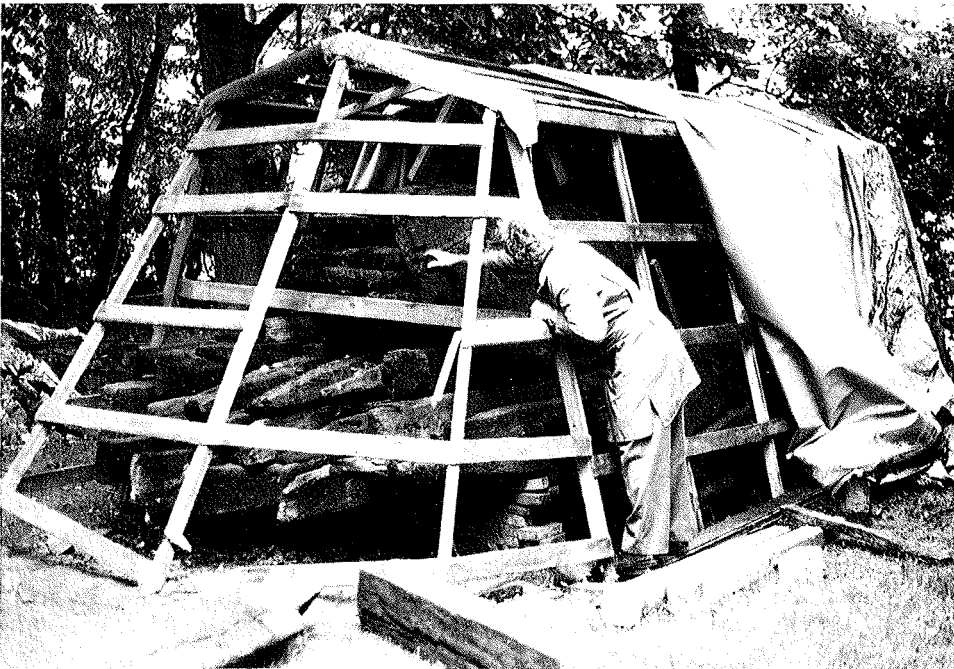
Abb. 9.14. Das Zeltmagazin im Park des Nissenhauses mit den eingelagerten Balken des historischen Nüstersiels. Einlagerung in einem winddurchlüfteten „Zeltdepot“ bei ortseigenem Westküstenklima
