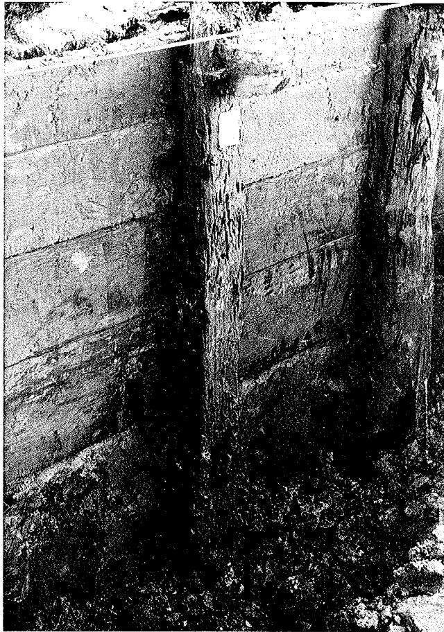
Abb. 10.22. Das hier abgebildete ältere Ostwerk (Ost I) zeigte nach der Aufgrabung im ganzen mittleren Abschnitt einen unbeschädigten, vollkommen intakten Bauzustand. Sowohl die Stammeichen als auch die zuunterst liegenden Planken zeigen nahe am Grund das Merkmal einer Zweitverwendung
