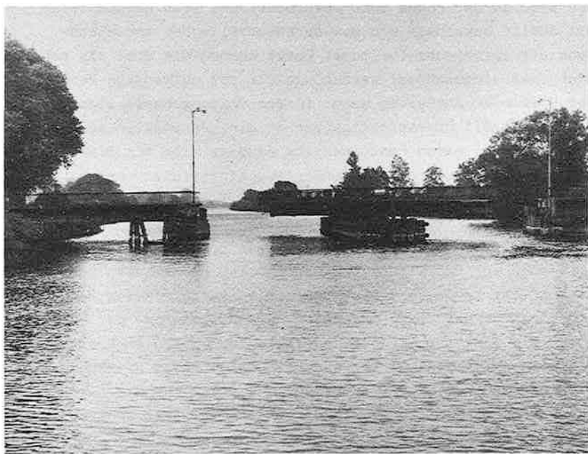
Bild 2 Manuelles Öffnen der Drehbrücke in Loitz
