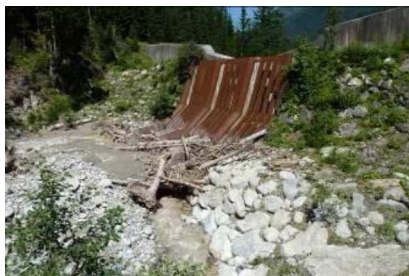
Abbildung 6: Konstruktionsdetail der wasserseitigen Abdeckung mit einem geeigneten Rechen vor dem Ereignis (Bild links) und nach einem Ereignis (Bild rechts). Wichtig ist der untere Tiroler Wehr ähnliche Teil im Bereich der Sohle
