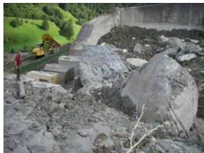
Abbildung 10: Murbrecher mit aufgelösten Scheiben und flachem Anlaufteil (Scheiben mit Stahlblech gepanzert) – Murbrechende Wirkung und Ausfilterung von Wildholz im Zuge eines Ereignisses (Beispiel Aubach 2017, Bild rechts).
