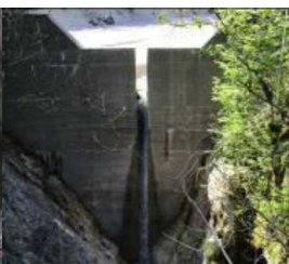
Abbildung 4: Schlitzsperrne – hohe Verklausungsanfälligkeit infolge Wildholz und hoher Instandhaltungsaufwand
