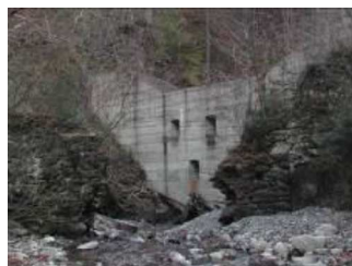
Abbildung 3: Großdolige Entleerungssperren - Wildholz verlegt die Öffnungen, danach erfolgt eine sofortige Verfüllung des geschaffenen Ablagerungsraumes
