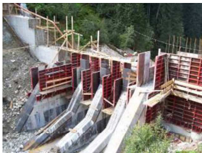
Abbildung 10: Murbrecher mit aufgelösten Scheiben und flachem Anlaufteil (Scheiben mit Stahlblech gepanzert) – Murbrechende Wirkung und Ausfilterung von Wildholz im Zuge eines Ereignisses (Beispiel Aubach 2017, Bild rechts).
