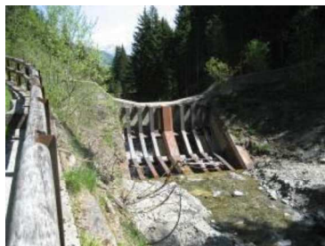
Abbildung 6: Konstruktionsdetail der wasserseitigen Abdeckung mit einem geeigneten Rechen vor dem Ereignis (Bild links) und nach einem Ereignis (Bild rechts). Wichtig ist der untere Tiroler Wehr ähnliche Teil im Bereich der Sohle
