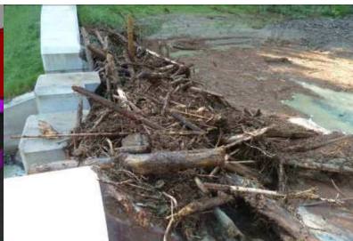
Abbildung 9: Eine flach geneigte Filterkonstruktion bewirkt ein aufschwimmen des Wildholzes sodass Teile des Geschiebes durch das Bauwerk durchtransportiert werden
