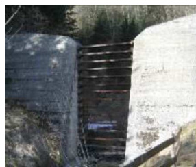
Abbildung 5: Balkensperren – Geschieberückhalt hinter den Balken
