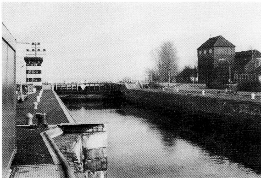
Bild 11 Schleusenammer Süd während der Absenkung
