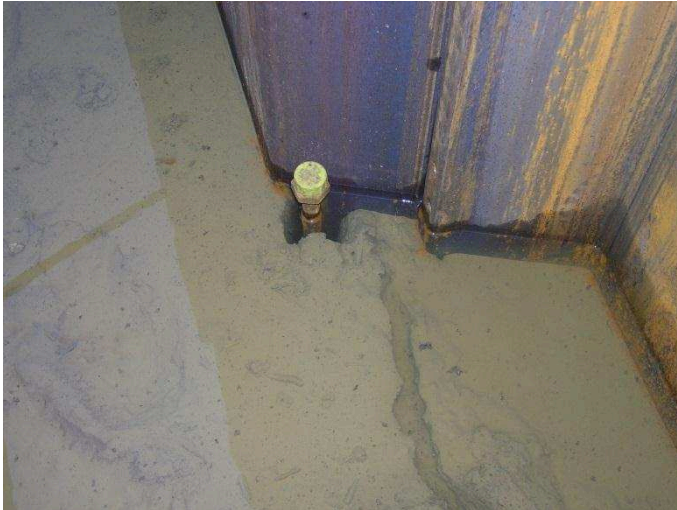
Bild 1: Durchdringung einer Spundwand durch eine Tondichtung
