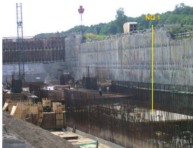
Bild 1: Baugrube Schleuse Sülfeld im Bereich Oberwasser mit dem Messquerschnitt NQ1
