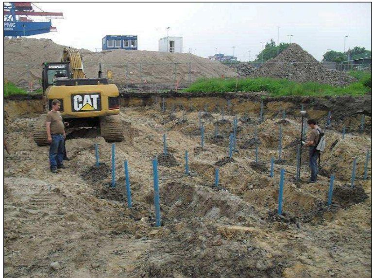
Bild 1: Kampfmittelsondierung für eine Baumaßnahme (Foto: KED, Hamburg)
