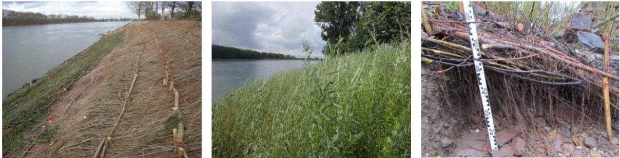
Bild 1: Weidenspreitlagen nach dem Einbau Ende 2011 (links), im August 2012 (mitte), Wurzelfreilegung im November 2012 (rechts)
