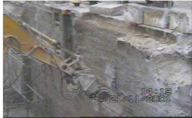
Wandabbruch mit Fräßbagger
