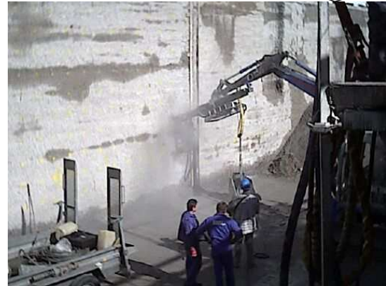
Hydraulikbagger mit Ankerbohrgerät
