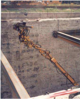
Bohrgerät mit über 15 m langem Gelenkarm
