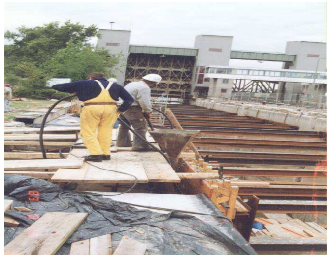
Einbau mit Fallrohr und Innenrüttler
