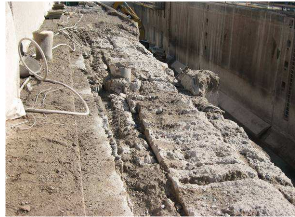
Ergebnis der Hochdruckwasserverfahrens
