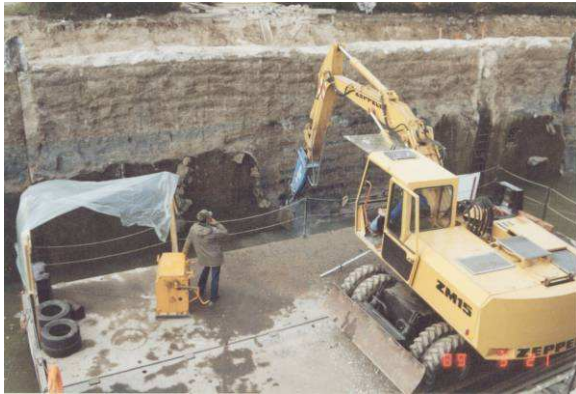
Wandabbruch mit Meißelbagger
