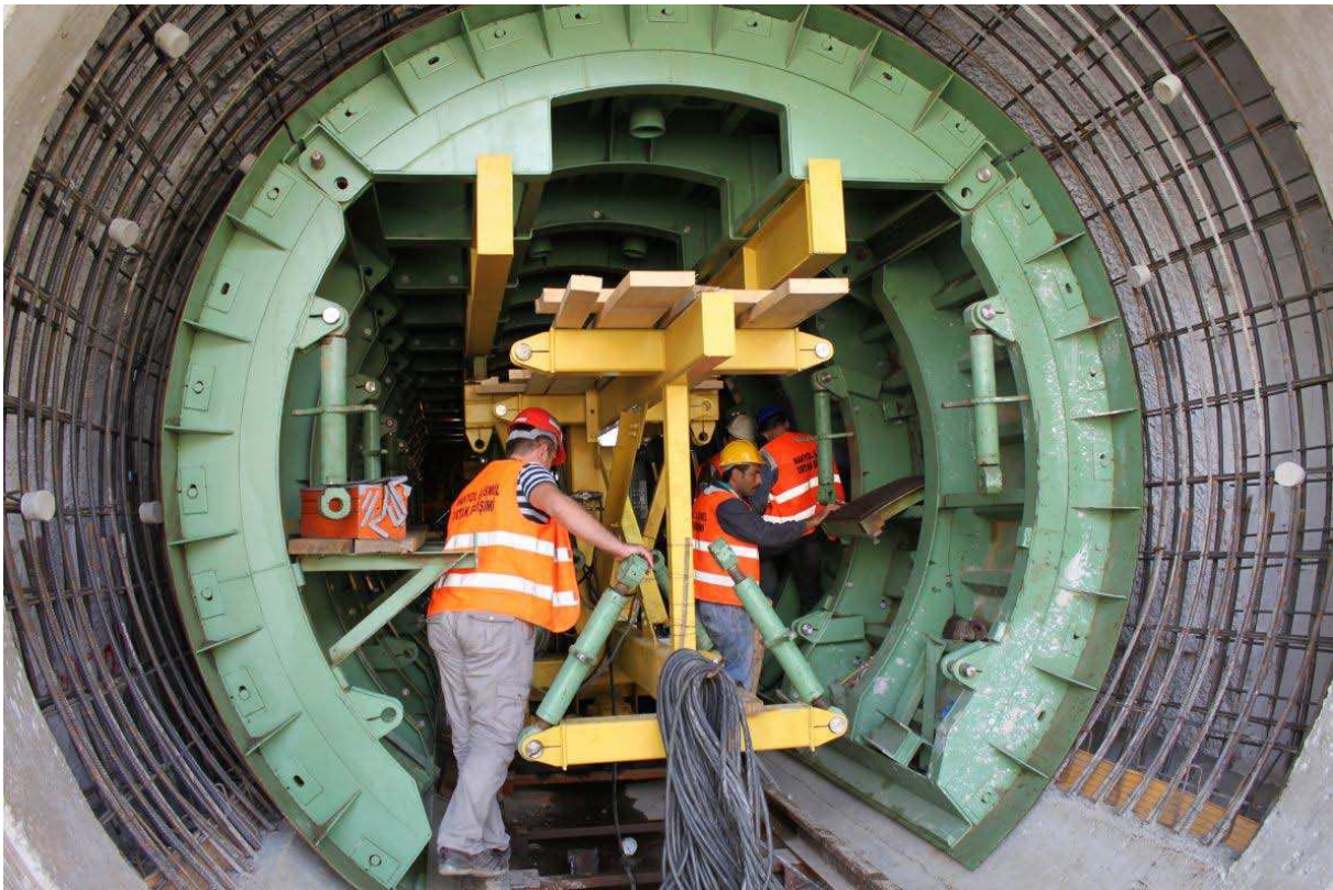
Abbildung 3 Schalwagen für die Betoninnenschale der Tunnel Yedigöl und Aksu
