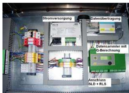
Abbildung 6 Schaltschrank mit Systemkomponenten (links) und Durchflussganglinie (rechts)
