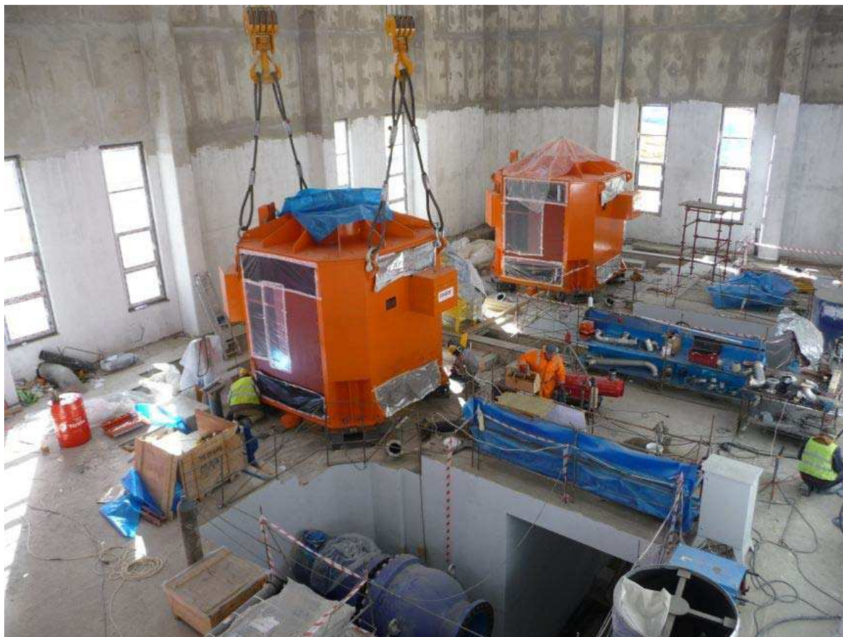
Abbildung 4 Krafthaus in Yedigöl, Einbau der Generatoren
