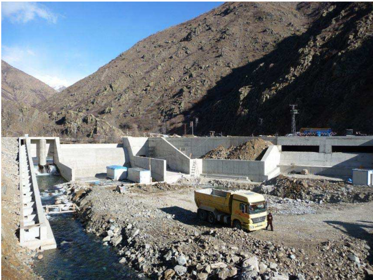
Abbildung 2 Wehranlage in Yedigöl mit Tiroler Wehr, Sandfang, Fischaufstiegsanlage und Kiesschleuse
