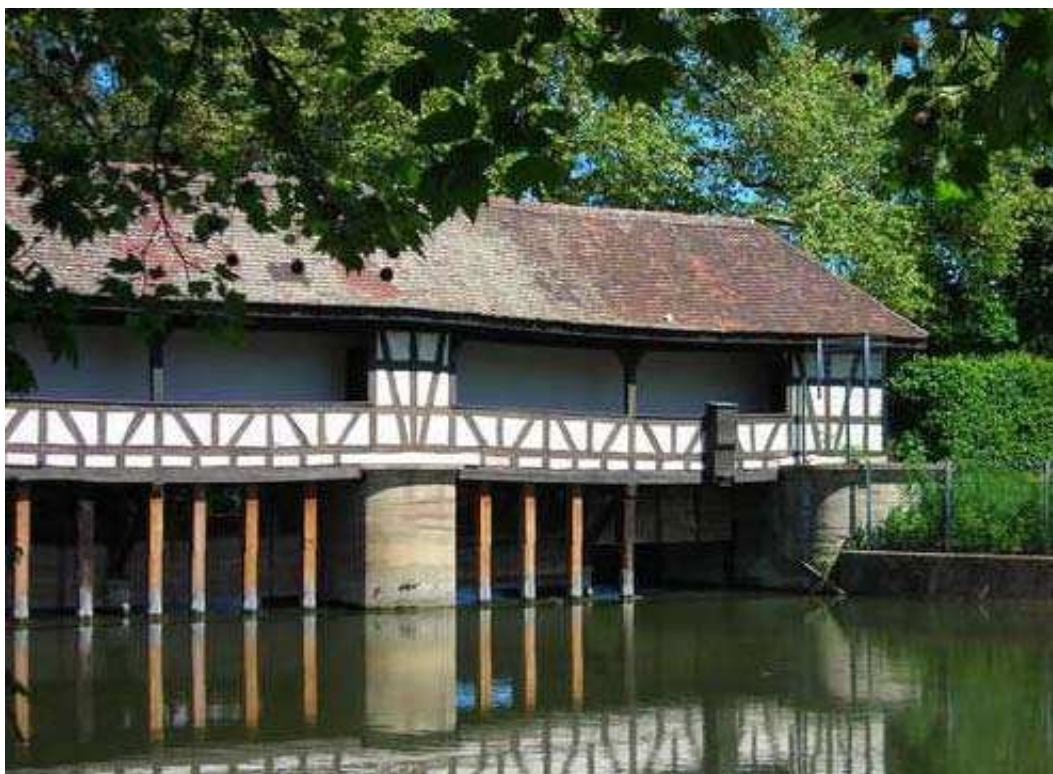
Abbildung 3 Historisches Wasserhaus, am Hammerkanal, Esslingen/ Neckar.
