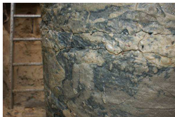
Abbildung 17: Freigelegter Pfahl 7 mit Rissbild
