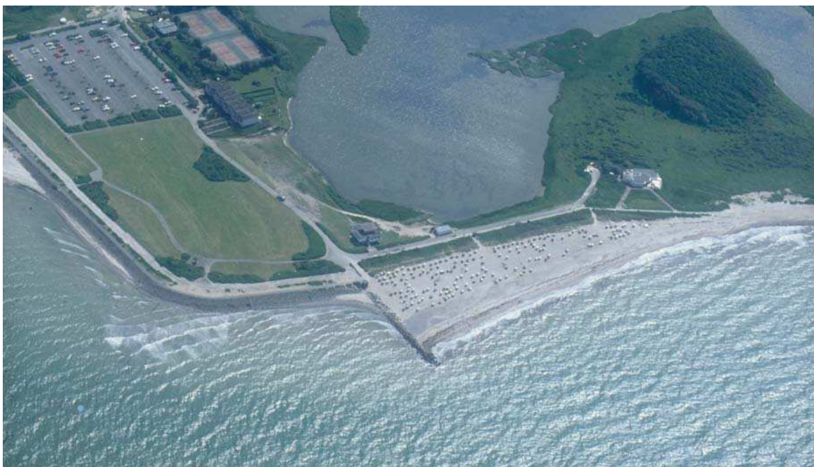
Abb. 4.27: Die „große Buhne“ an der Grenze Eichholzniederung/Steinwarder bei Heiligenhafen. Der Akkumulationswirkung dieser Buhne steht die Lee-Erosion und damit die verstärkte Belastung des Deiches durch den fehlenden Strandpuffer gegenüber (Aufnahme vom Juli 1994, K. SCHWARZER)
