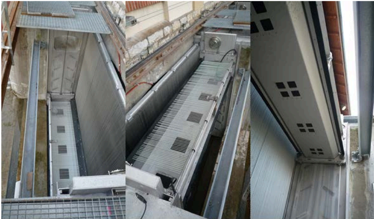
Abbildung 6: Fischhebetrog im Trockenem (links: in tiefer Position vor Fischschonrechen; Mitte: hohe Pos. mit aufgelegtem Fischschutzkamm; rechts: von unten mit Öffnungen zum Füllen beim Absenken; Fotos: IUB Engineering AG)
