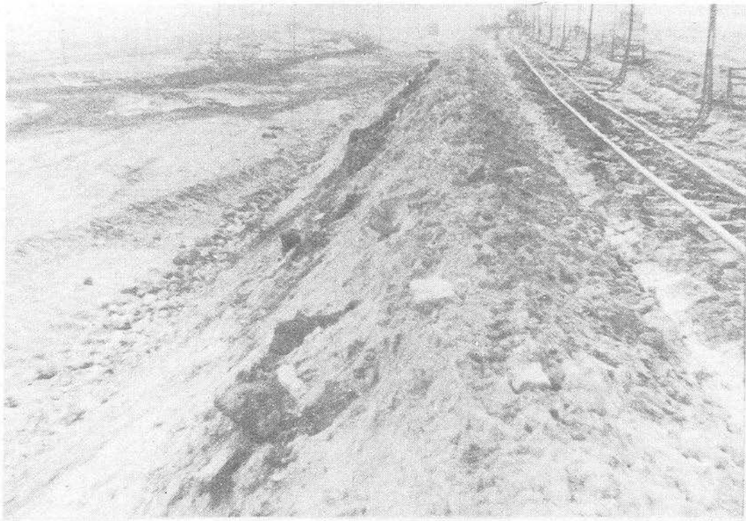
Bild 3 Typisches Dammschüttmaterial
