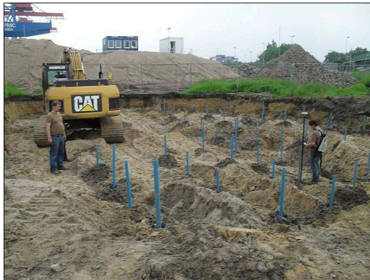
Bild 1: Kampfmittelsondierung für eine Baumaßnahme (Foto: KED, Hamburg)
