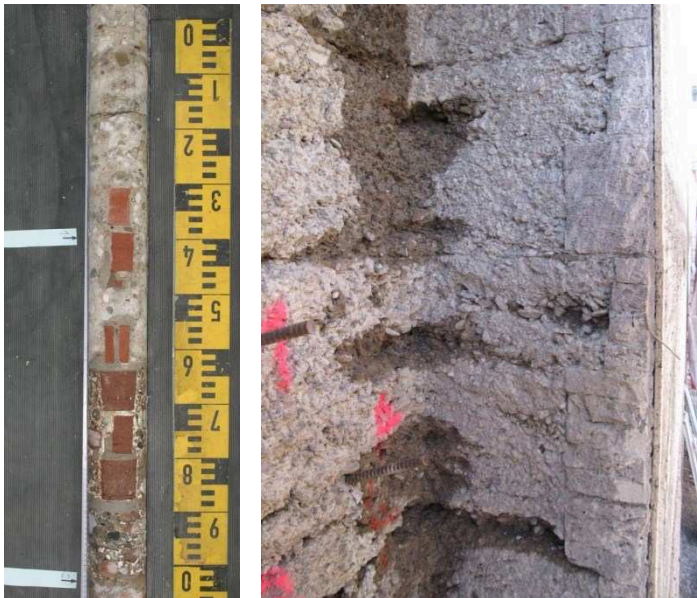
Bild 1: Injizierter Bohrkern (links), Verbund Vorsatzschale-Kernbeton (rechts)
