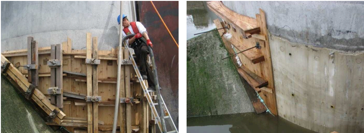
Bild 1: Reparaturfläche Eidersperrwerk (a) während des Betoneinbaus (b) fertige Fläche
