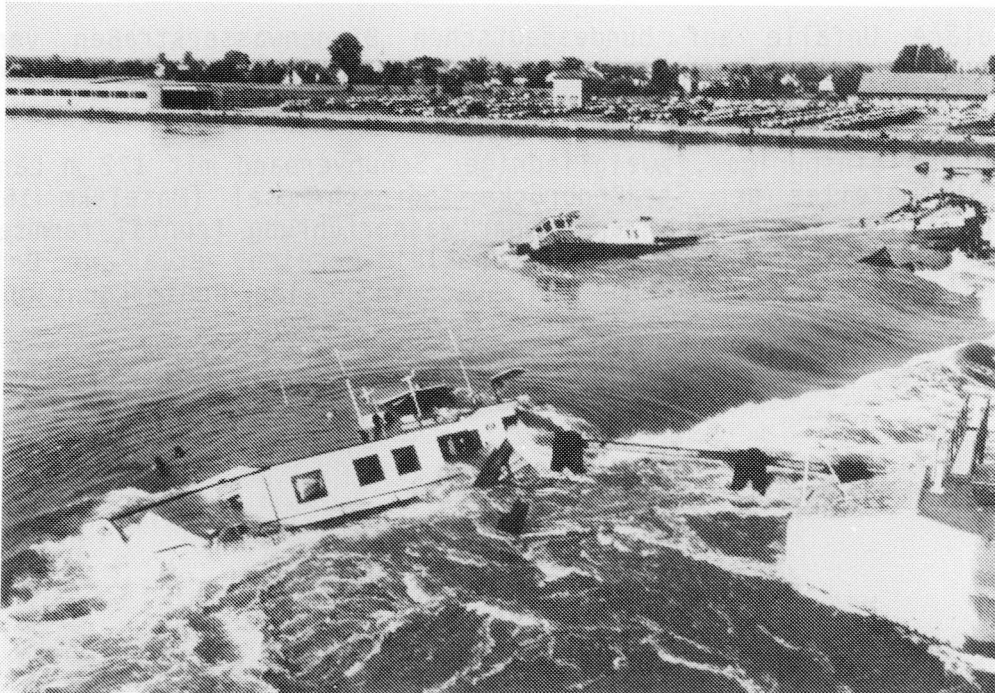
Bild 2 Schiffs-kollision 1987 an der Eisenbahnbrücke über den Rhein bei Karlsruhe-Maxau
