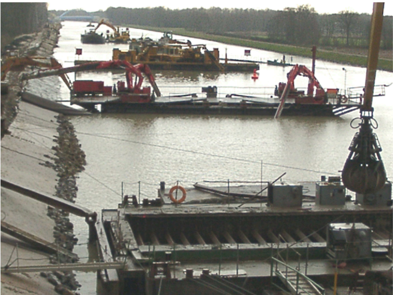
Bild 1: Gerätezug zum Einbau eines neuen Deckwerks mit Tondichtung
