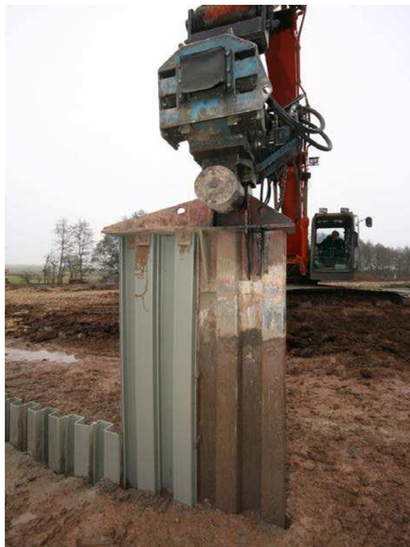
Abbildung 1: Kunststoffbohle mit vorlaufender Mutterbohle
