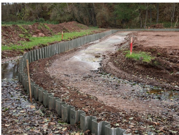
Abbildung 4: Einbau der Kunststoffbohle und fertige Spundwandkonstruktion
