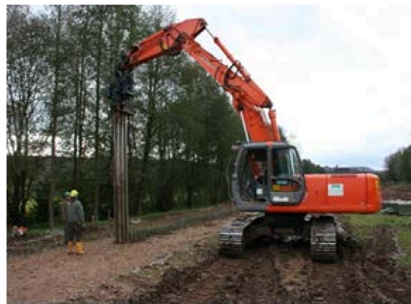
Abbildung 4: Einbau der Kunststoffbohle und fertige Spundwandkonstruktion
