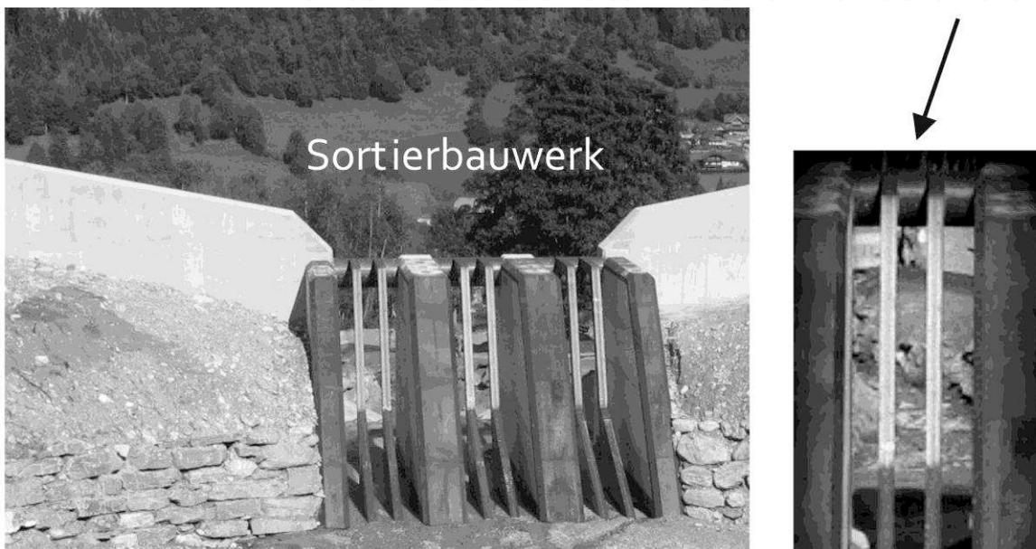
**Abbildung 5:** Sortierwerk mit Stahlrechenkonstruktion zur Geschiebebewirtschaftung
