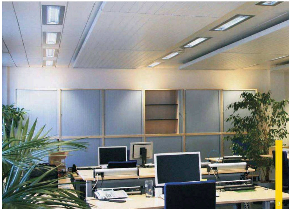
Beispiel einer Deckenstrahlheizung für die Umkleideräume (sunline)
