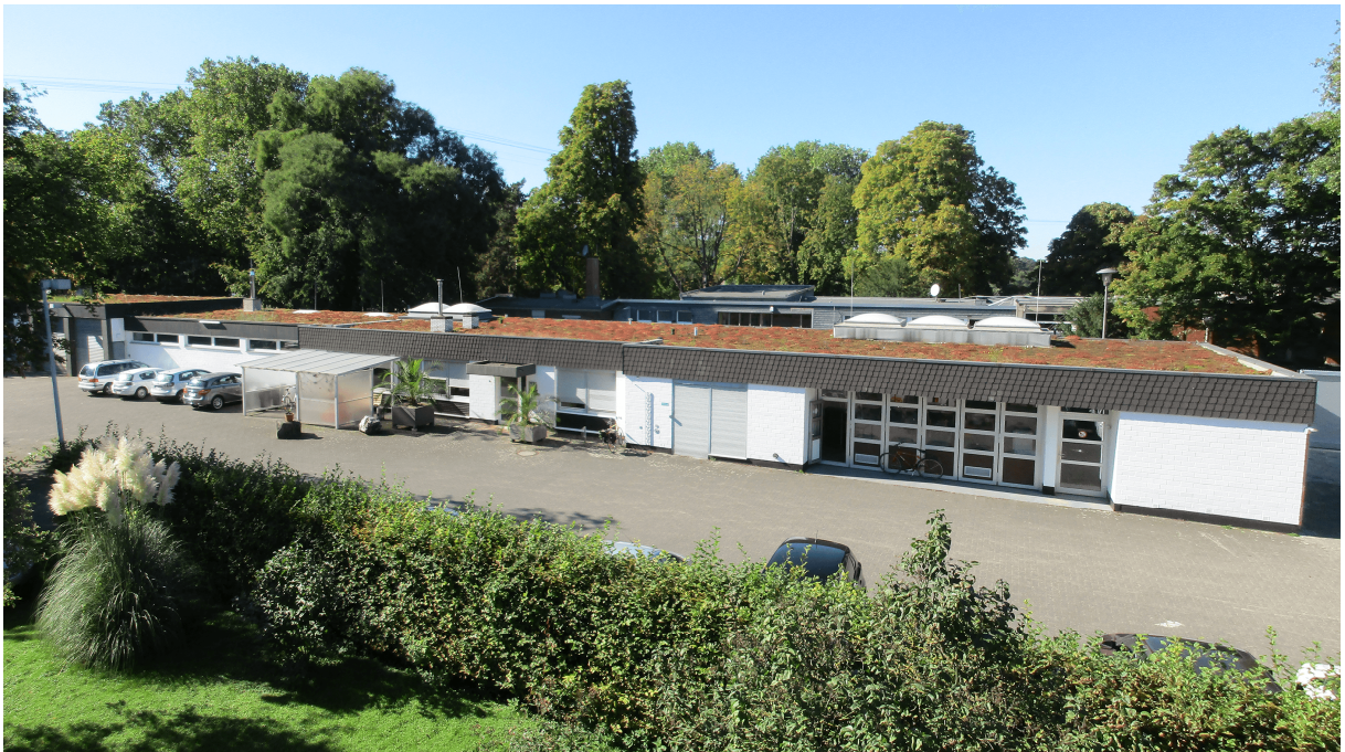
Bild 55: Betriebswerkgebäude Außenbezirk Köln
