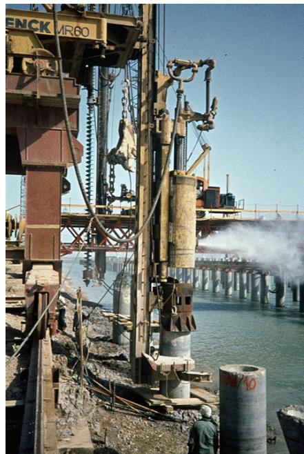
*Bild 25: Pfahlrammung*
