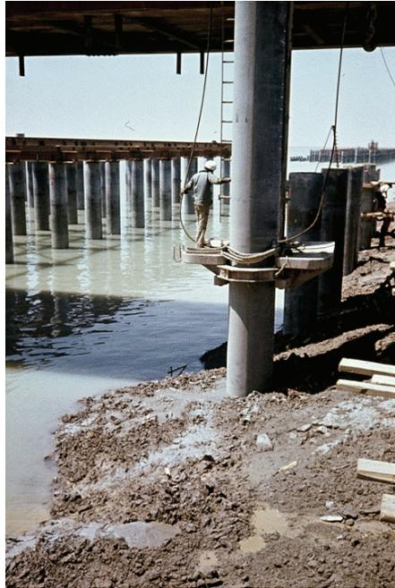
*Bild 24: Aufsetzen des Pfahles auf die Bohrung*
