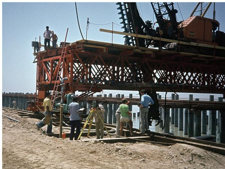
*Bild 23: Schrägbohrung für geneigten Pfahl*
