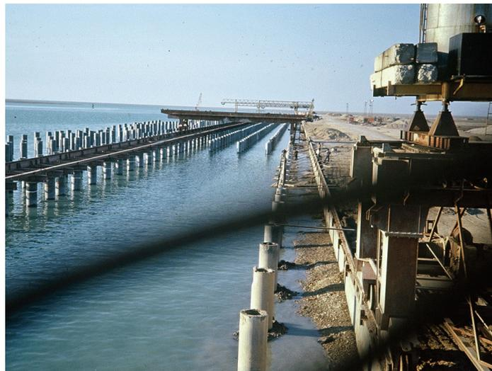
*Bild 8: Pfahlrammung*
