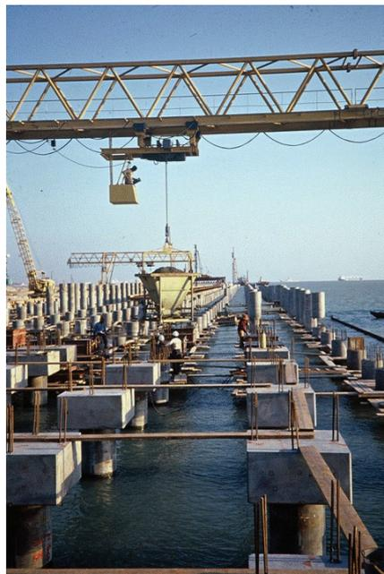
*Bild 27: Pfahlkopfherstellung*
