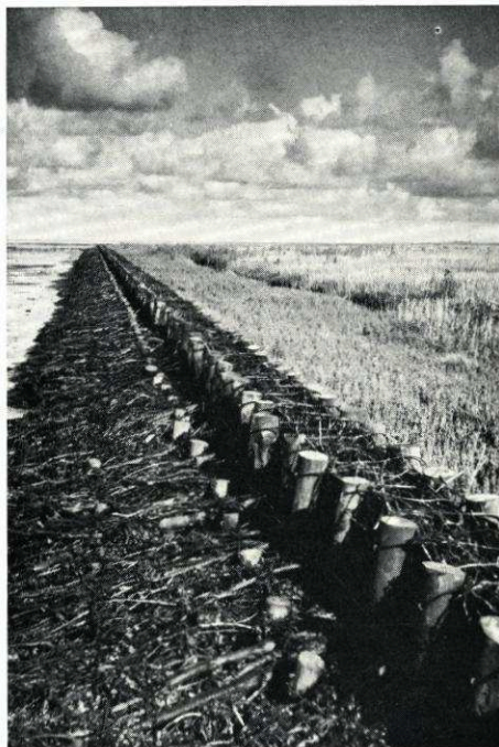
Abb. 3. Buschlahnung mit Spreutlage – vordere Querlahnung, rechts dichter Queller- und Spartinaebewuchs
