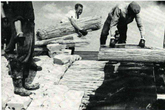
Abb. 6 Betondeckwerksteine mit horizontalem und vertikalem Verbund werden auf eine die Folie schützende Rohrmatte verlegt
