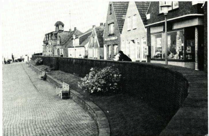
Abb. 23 Deichmauer am Fischerhafen Neuharlingersiel
