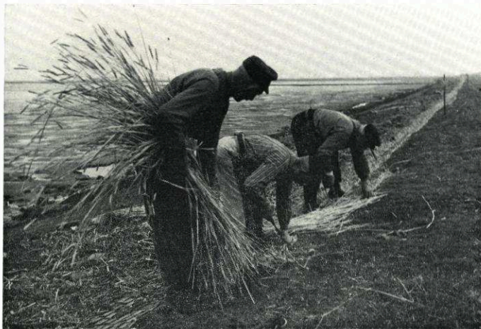
Abb. 32 Besticken von Rasensoden; spät angedeckte, bis zum Winter nicht mehr verwurzelnde Soden werden mit aus Stroh gedrehtem Strick auf dem Untergrund festgenäht (besticken)
