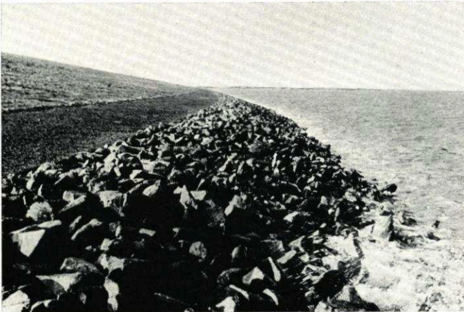
Abb. 18 Rauhdeckwerk mit oberhalb angrenzender Mastix-Eingußdecke auf dem Hauptdeich westlich von Bengersiel
