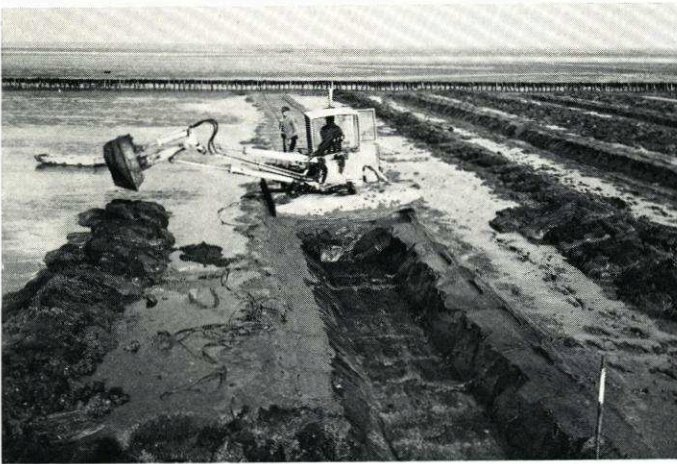
Abb. 9 Grüppenbagger im Einsatz – Zugseil an der Querlahnung im Hintergrund befestigt
