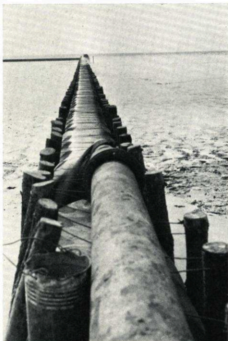
Abb. 7. Lahnung aus PE-Gewebeschlauch wird im Spülverfahren mit Sand gefüllt
