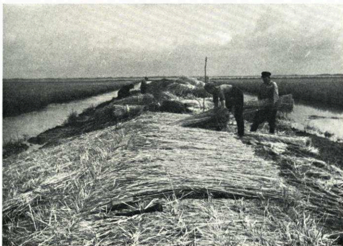
Abb. 33 Herstellung des Strohbesticks; die nicht begrünte Deichböschung wird flächenhaft mit Stroh bedeckt (Strohdach) und mit aus Stroh gedrehtem Strick auf dem Boden festgenäht (besticken)
