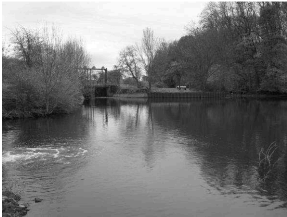
Abbildung 5: Kolkbereich mit Blick auf die Südschleuse
