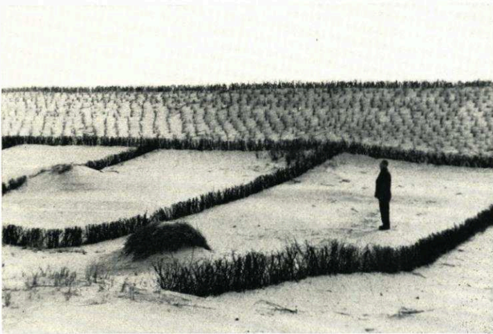
Abb. 13. Das Anlegen von Feldern aus winddurchlässigen Sandfangzäunen im inneren Dünental um dies vor Aus- blasungen zu schützen und auch hier eine weitere Auf- höhung zu erreichen (siehe auch Abb. 12) Aufn. E. WOHLBERG
