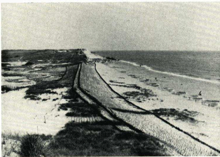
Abb. 11. Neuerrichtete Randdüne im Sommer 1963. Sie hat hier bereits wieder eine Höhe von +6,0 m NN erreicht. Deutlich sichtbar sind die zwei Reihen Sandfangzäune auf der Krone und zur Sicherung am Fuß sowie die Strandhaferbepflanzung. Blickrichtung nach Süden Aufn. E. WOHLBERG
