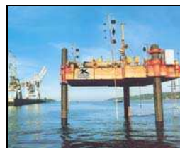
Bild 3: Drucksondierungen auf dem Wasser
