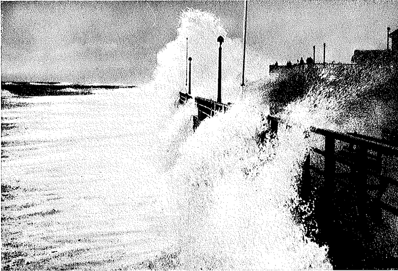
Abb. 9. Anprall der Wellen bei Sturmflut gegen die Strandmauer vor Westerland.
