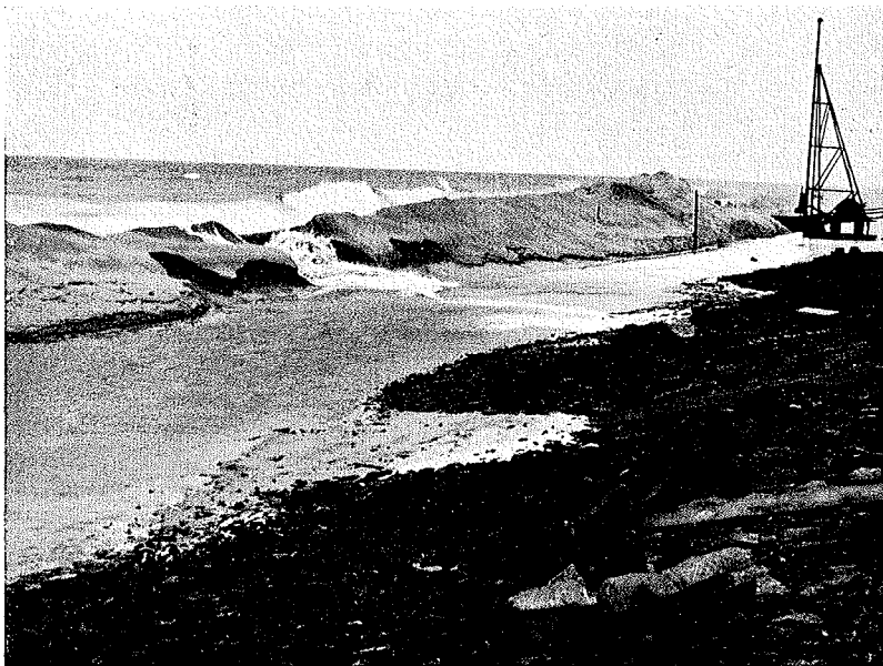
Abb. 16. Sturmflut bricht in die Baugrube ein.
