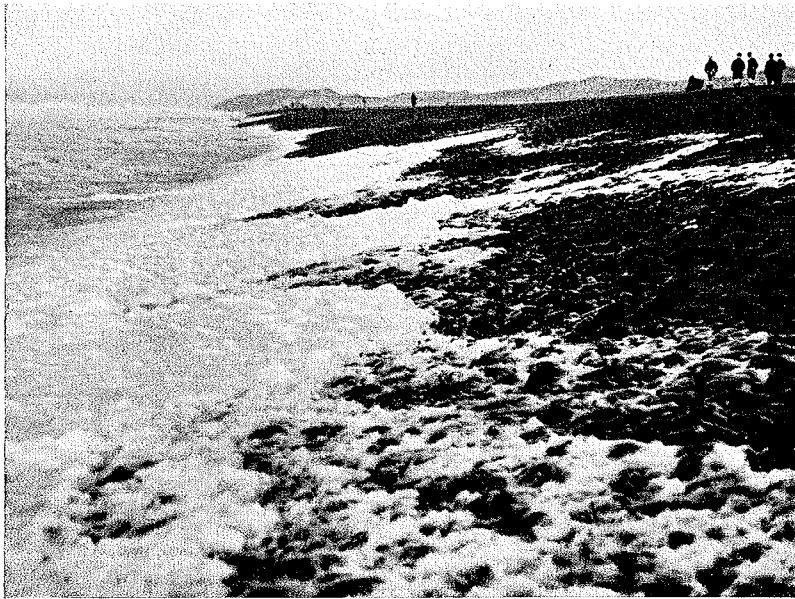
Abb. 15. Auslaufen von Brandungswellen auf der Deckwerksböschung.
