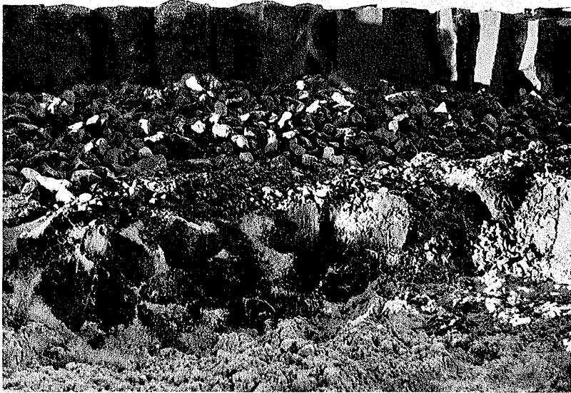
Abb. 13. Querschnitt der Böschungsbefestigung (40 cm Basaltsäulen, 30 cm Schotter und Splitt, 40 cm Klei).
