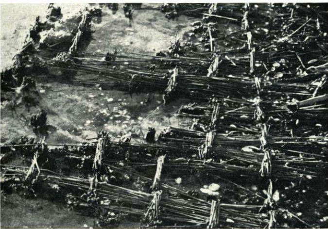
Abb. 14. Die allzu starre, ihrer Blattspreiten durch Erosionswirkung entblößte Rethlage unterliegt schnell der Auflösung. Eine Regeneration der ursprünglich geschützten Sodenvegetation ist nicht möglich, daher keine biogene Einverleibung in den zu schützenden Standort Dez. 1941. Aufn. E. WOHLBERG
