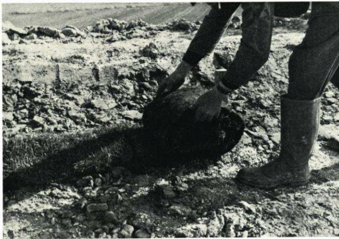
Abb. 8. Das Ausrollen der Rollsoden in meterlangen Bändern auf der zu sichernden und zu be- grünenden Deichböschung Juni 1965. Aufn. E. WOHLBERG
