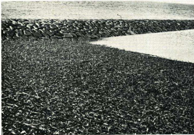
Abb. 12. Mit Reth bestickte untere Außenberme der Insel Pellworm. Hier verwendet man das in den Gräben und den alten Deichpütten (Erdentnahme) wachsende Schilf (Reth, Phragmites ) Dez. 1941. Aufn. E. WOHLBERG
