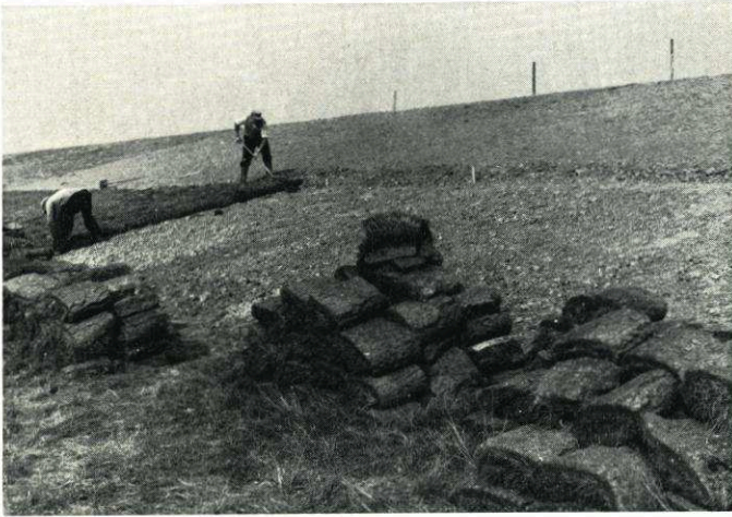
Abb. 7. Ein Depot von angefahrenen Rollsoden an der Verwen- dungsstelle der mittleren Deichböschung Juni 1965. Aufn. E. WOHLBERG
