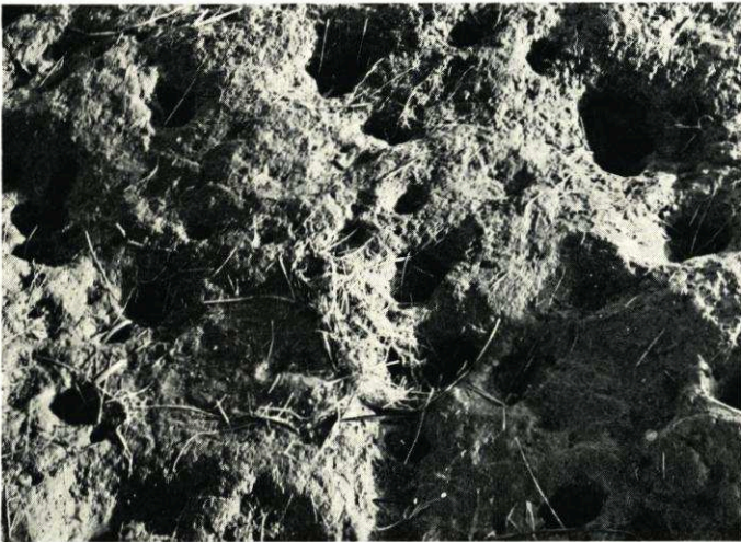
Abb. 28. Deichböschung nach der Sturm- flut vom Februar 1962. Die Sturmflutwellen haben die Grasnarbe zerstört und den inneren, von Maulwürfen und Mäusen durchlöchernten Deich- kern freigelegt Febr. 1962. Aufn. E. WOHLBERG
