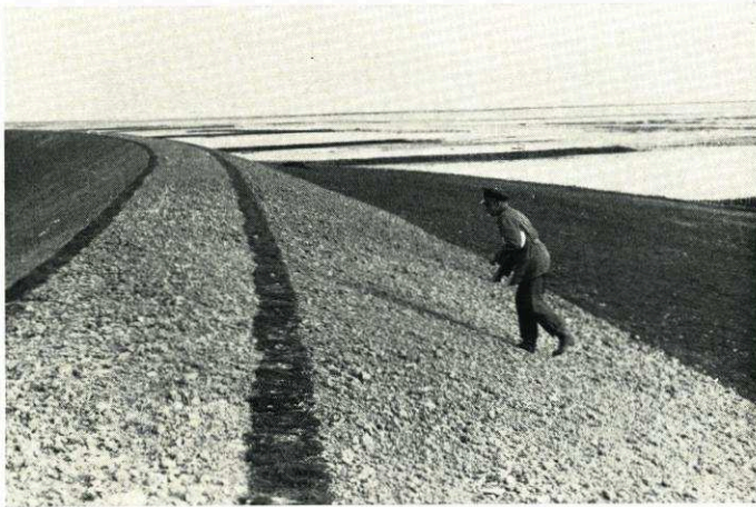
Abb. 22. Schema der Besodung und Ansaat eines modernen Seedeichs. Zuunterst, fast noch im Einflußbereich des Meeres, werden Andel-Soden ( Puccinellia maritima ) angedeckt, daran anschließend im mittleren Bereich der Böschung Rotschwinge-Soden ( Festuca rubra litoralis ), weiter oben als Abschluß der Besodungszone Süßgras-Soden ( Lolieto-Cynosuretum ). Daran anschließend anstelle von Besodung nur noch Ansaat mit standortgerechten Süßgräsern
