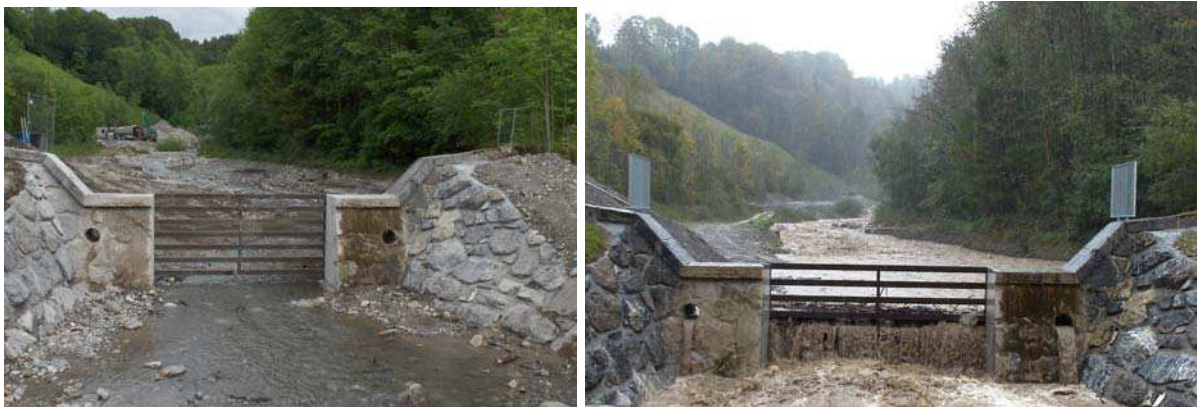
Abbildung 3: Umbau der Geschiebestausperre bei hm 38,00 in eine Balkensperre
