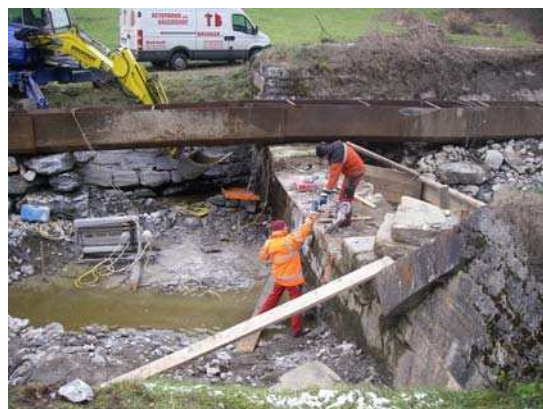
Abbildung 4: Schwimmschulwehr vor Maßnahme (Foto links), Beginn Umbau mit Wasserhaltung (Foto rechts)
