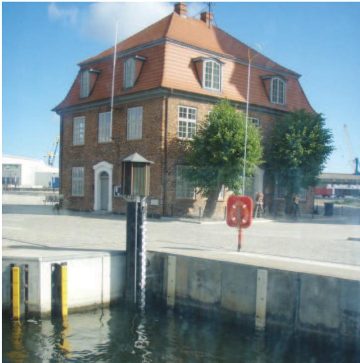
Abbildung 3: Die moderne Pegelanlage bei der Messstelle Wismar Baumhaus, erkennbar an der geringen Größe des Pegelhäuschens, liefert hoch aufgelöste Wasserstandzeitreihen (Foto: SEIB 2009).
